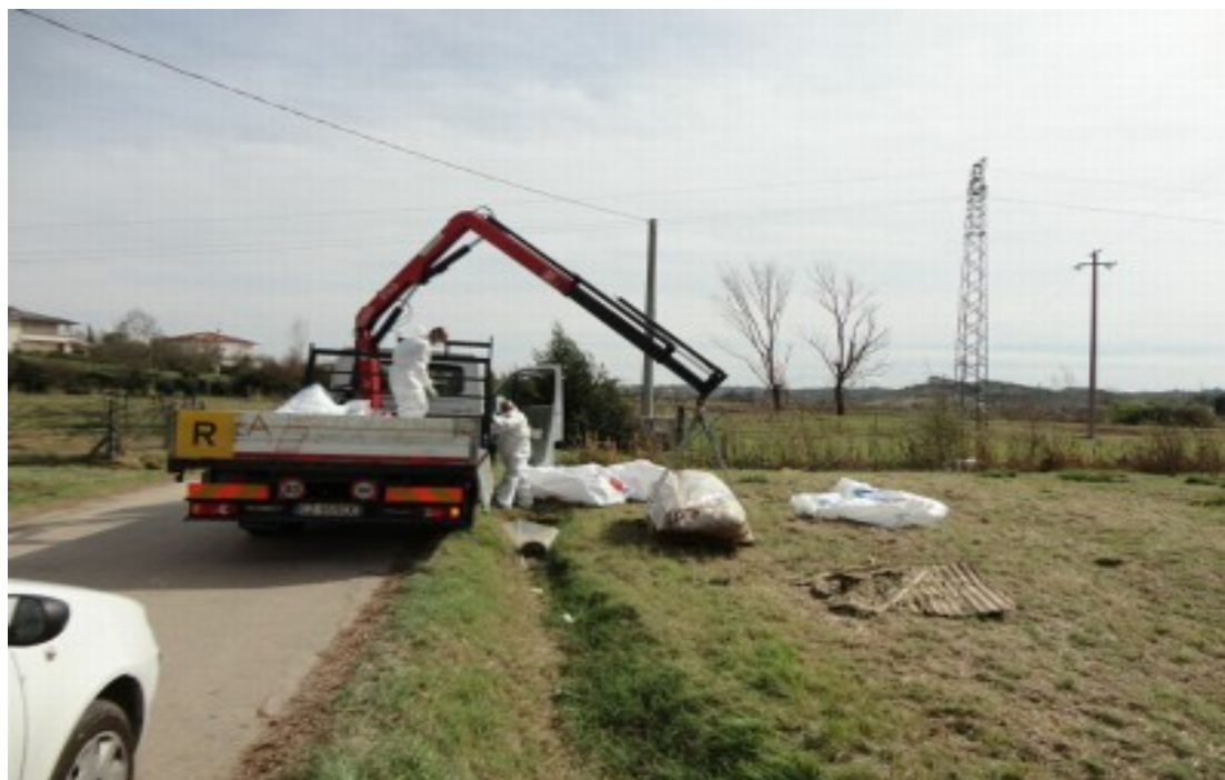
Figura 20 - Frammenti di cemento-amianto in terreno agricolo a Cerreto Guidi – settembre 2014
