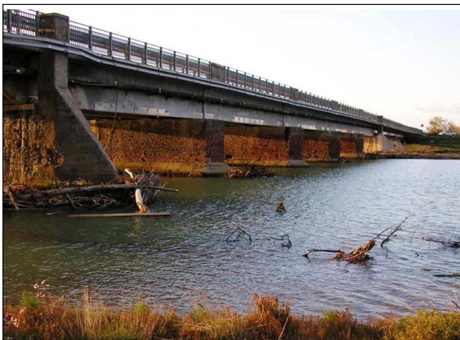
FIGURA 2-2: VISTA DEL PONTE DELLA STRADA STATALE AURELIA N. 1.
