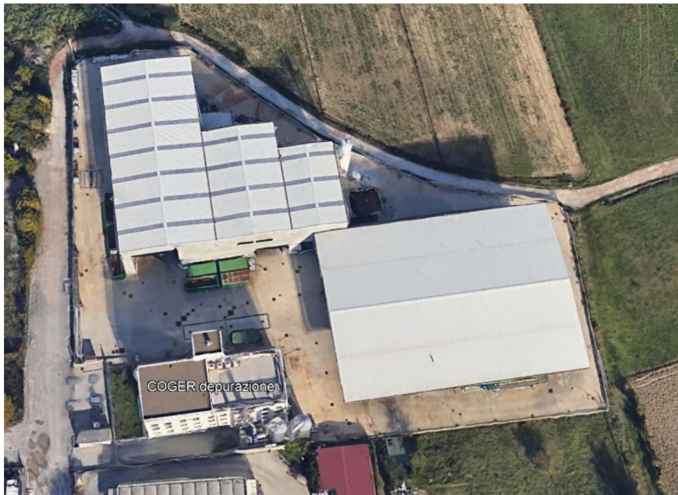
Fig.1 – Vista aerea (non orientata) dello stabilimento IPPC di via Amendola Signa (FI), gestito da CO.GE.R. S.r.l.
