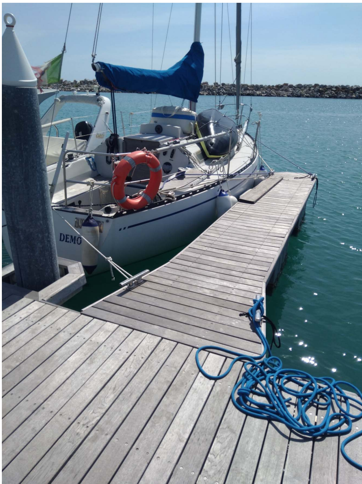
Foto 12.3 Zona sud del porto, pontile con sistema di ormeggio finger.
