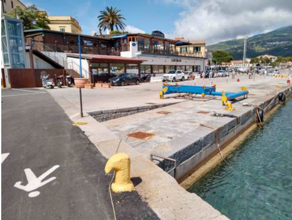
Vista della banchina dell'ormeggio
