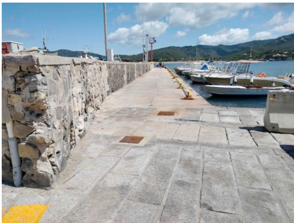
Vista della pavimentazione in pietra presente lungo alcuni tratti dell'ormeggio.
