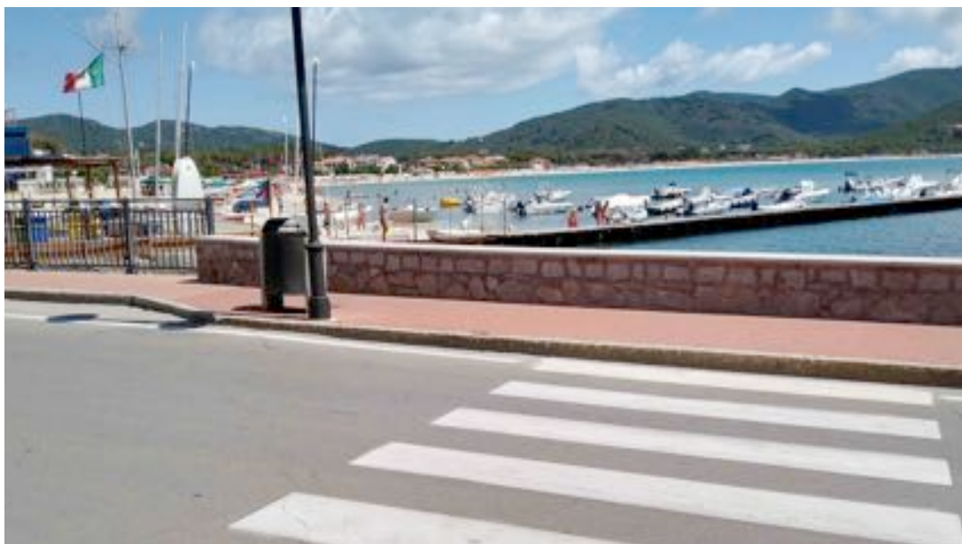
Vista dell'attraversamento lungo il molo
