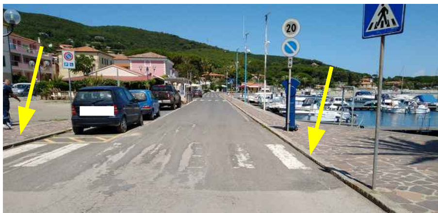
Posto auto riservato lungo la strada, si noti la mancanza dei raccordi con i marciapiedi.
