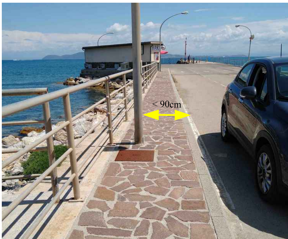
Restringimento del marciapiede dovuto all'ingombro del palo di illuminazione.
