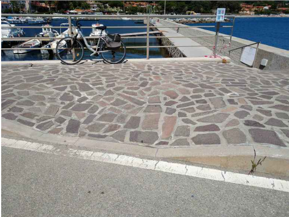
Percorsi pedonali rialzati rispetto alla viabilità interna
