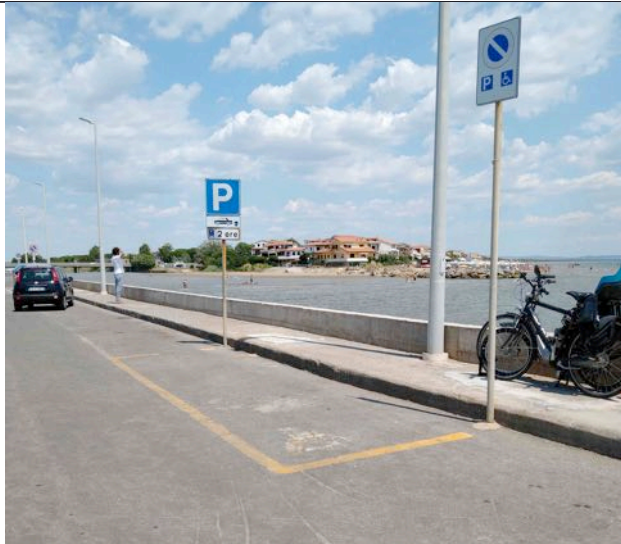
Vista del marciapiede interno che risulta di larghezza <90cm
