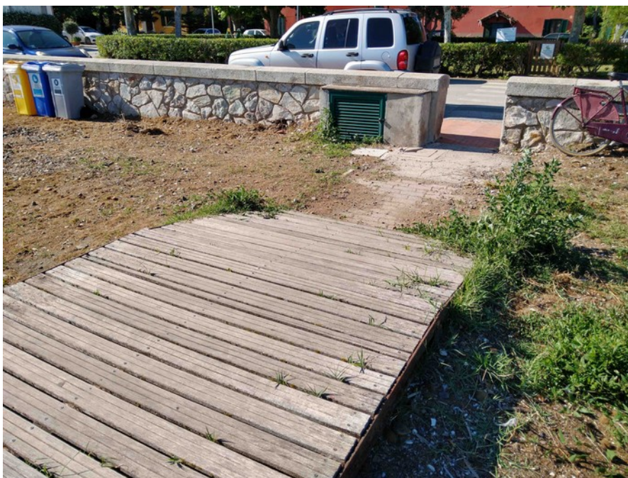
La rampa di raccordo nella zona d'ingresso all'area dell'ormeggio.
