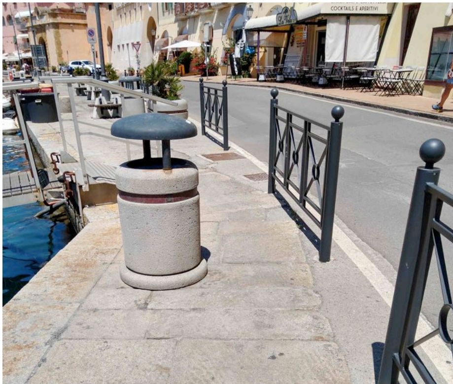
Vista di una strettoia dovuta ad un porta rifiuti posizionato in maniera errata.
