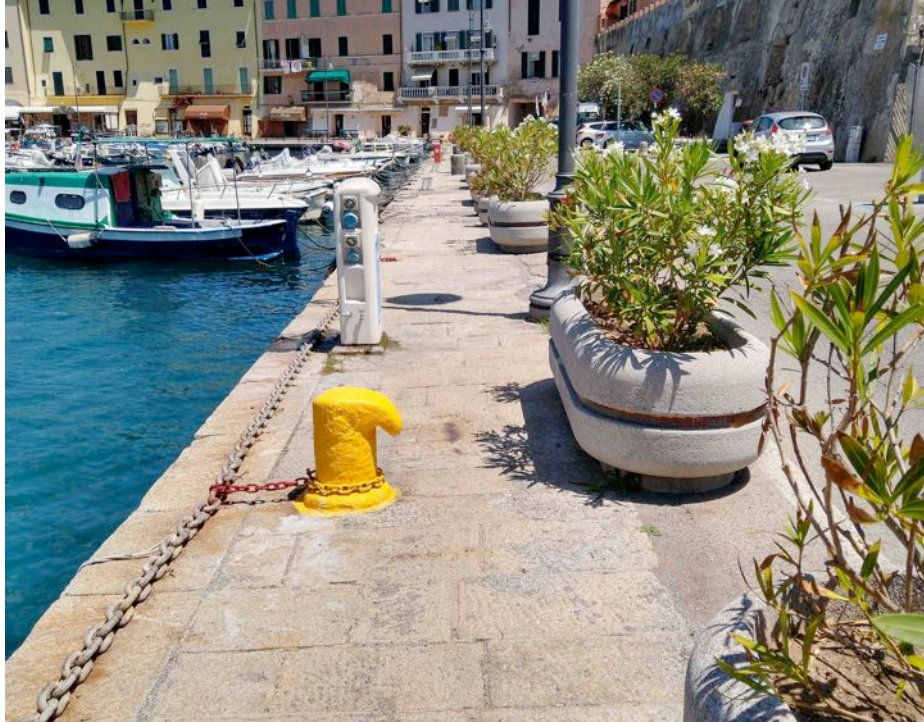
Vista di una strozzatura dovuta ad una bitta e il posizionamento errato della fioriera.
