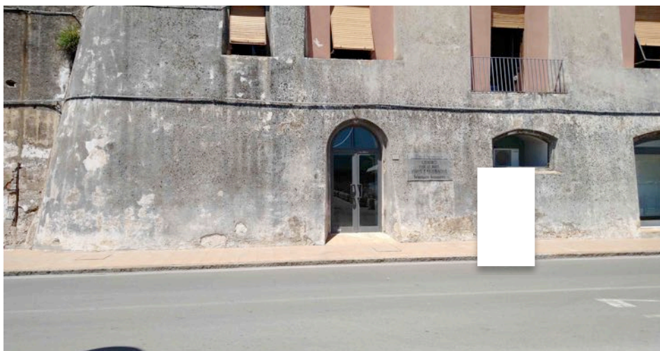
Vista dell'ingresso dei bagni posti sul lato opposto della strada rispetto al molo.
