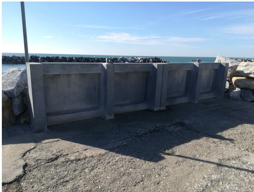
Foto 2 – Scivolo alaggio paratie metalliche rimovibili
