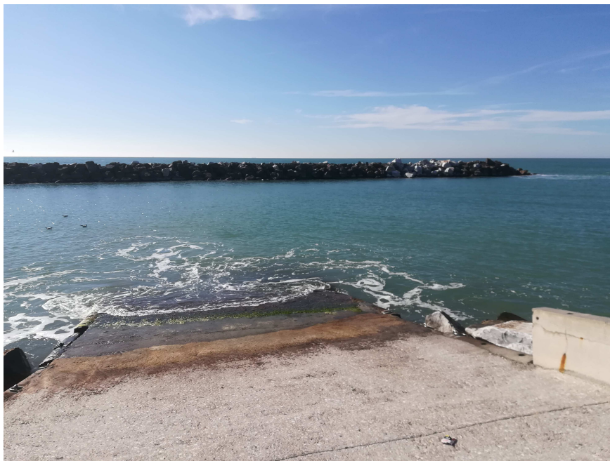
Foto 1 – Vista scivolo alaggio frontalmente protetto da barriere emerse
