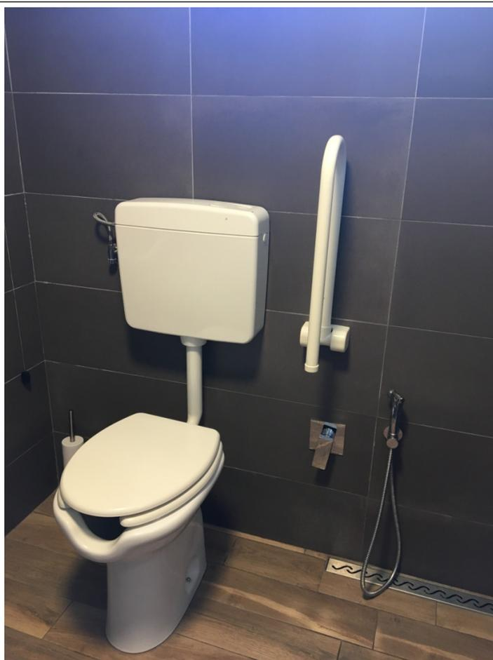
Foto. 10.1) Tipologia di bagni accessibili all'interno della struttura portuale
