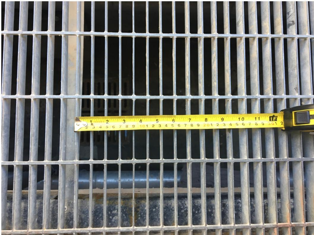
**Foto 6.3)** Tipologia di grigliati a pavimento presenti all'interno dell'area del porto
