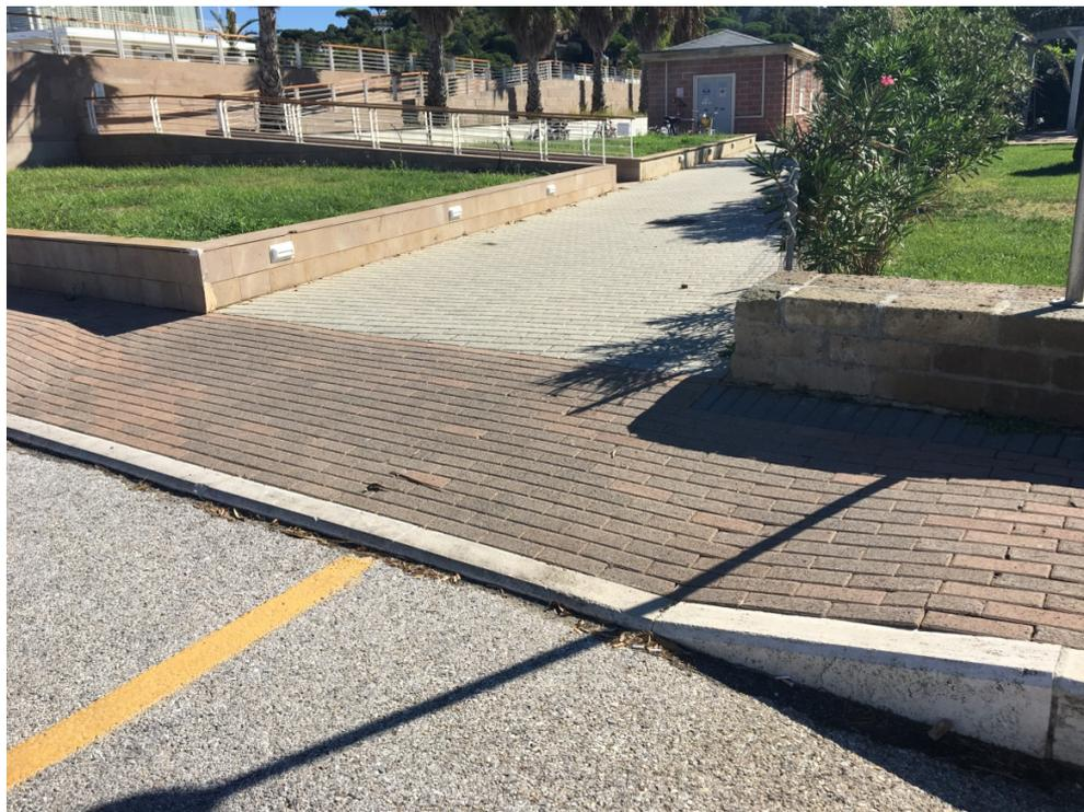
**Foto 3.1** Esempio di criticità locale, intersezione tra marciapiede (fronte mare) e percorso pedonale/carrabile
