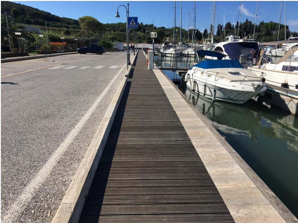
**Foto 3.2)** Il percorso pedonale che costeggia il bacino del porto è complanare al percorso carrabile, accessibile, protetto verso la carreggiata da un cordolo in rilievo e garantisce una elevata comunicatività ambientale grazie all'alto contrasto cromatico tra le superfici di calpestio che lo caratterizzano.
