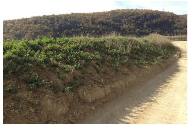
Figura 10 - Argine in terra lungo la viabilità di cantiere
