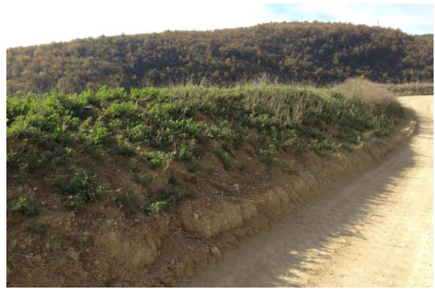
Figura 11 - Argine in terra lungo la viabilità di cantiere
