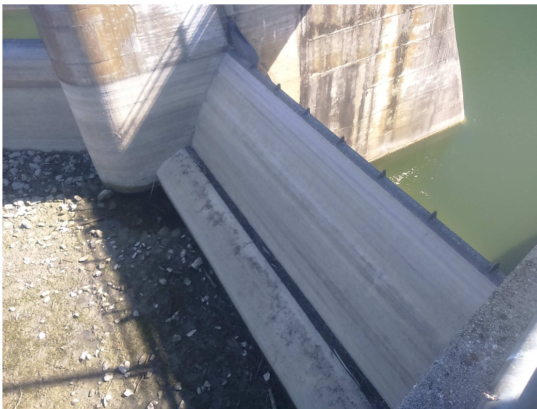
Fig. 5.3: paratoia a ventola della diga di Bilancino
