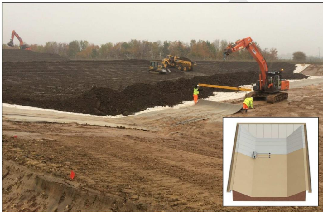
Fig 1. Tipica installazione di MacLine GCL (srotolare il rotolo perpendicolarmente alla scarpata; srotolarlo dalla sommità al piede)
