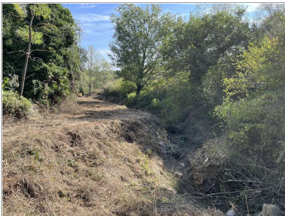
Foto 2 - Tratto del Fosso Cavernano interessato da erosione e smottamenti (vista da sud).
