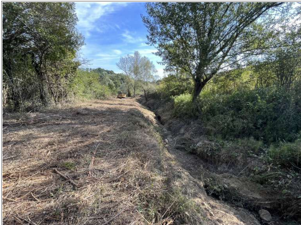
Foto 4 - Tratto del Fosso Cavernano interessato da erosione e smottamenti (vista da sud).
