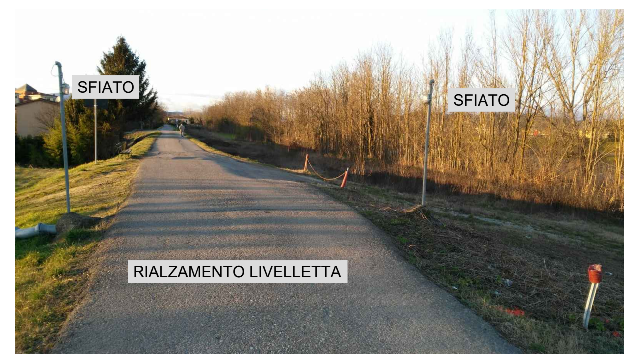
ATTRAVERSAMENTO DI VIA ARGINI ARNO DELLA TUBAZIONE Ø100 (Vista verso Nord)
