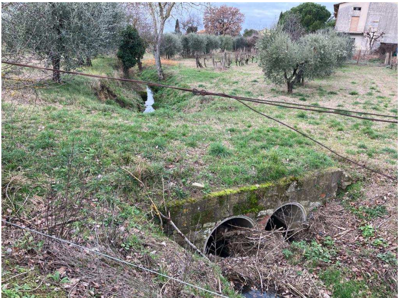
ATTRAVERSAMENTO CON TUBAZIONI IN CLS – SEZIONE TRA 207 E LA 210 – VISTA DA MONTE
