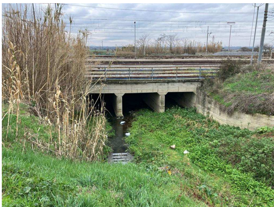
FIGURA 11: SCATOLARI SOTTO LA FERROVIA - FOTO DA VIA CADUTI SUL LAVORO VISTA DA MONTE – SEZIONE 180
