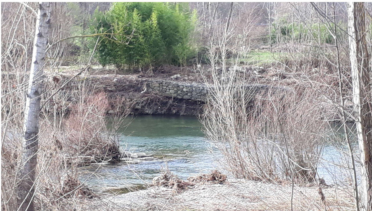
Foto 4 – Scalzamento al piede gabbionata esistente
