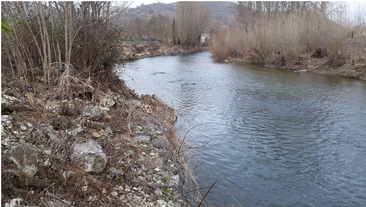
Foto 3 – Gabbionata esistente in rovina
