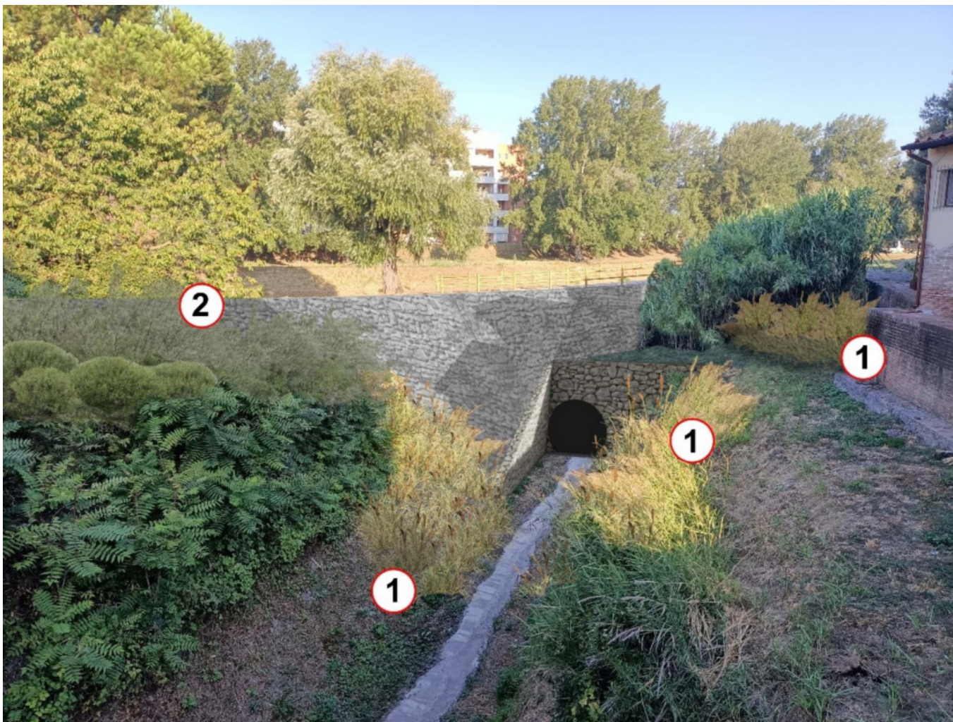
Fig 9.4: fotoinserimento argine rivestito in pietra con inserimento piantumazione mista per mitigazione ambientale con essenze Phracimites Australis, Typha Latifolia (ID.1); Salix Eleagnus, Salix Cinerea e Salix Purpurea (ID.2)
