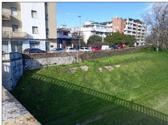
Figura 8-4 Muro arginale da rivestire
