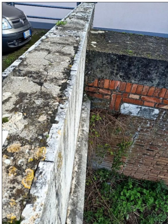
Figura 7-5 – Particolare delle condizioni della spalla del ponte Napoleonico in destra idraulica (lato monte)
