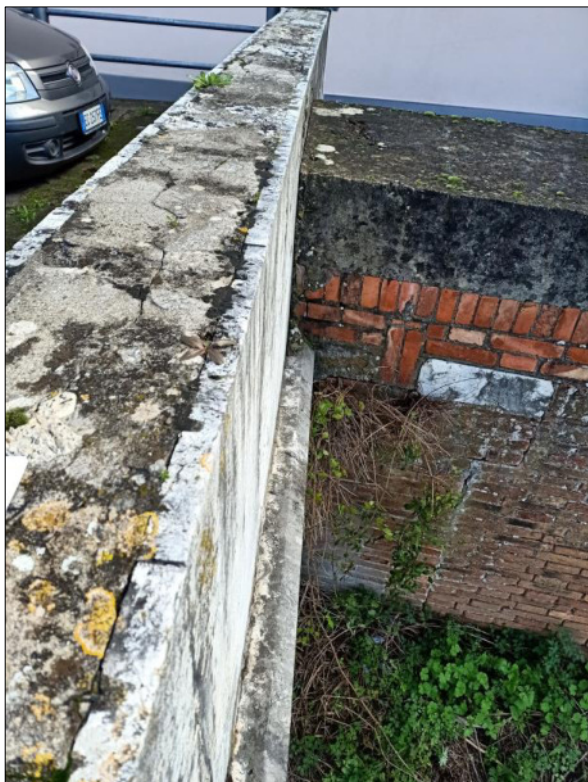
Figura 4-5 – Particolare delle condizioni della spalla del ponte Napoleonico in destra idraulica (lato monte)
