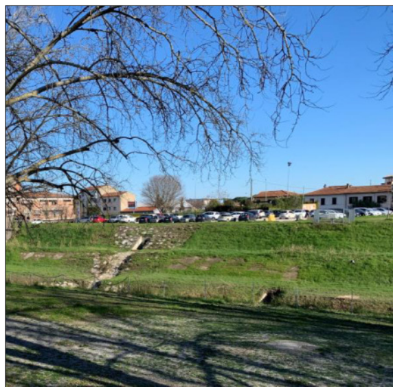
Figura 5-2 – scarichi del reticolo minore rivestiti in pietrame intasato in cls
