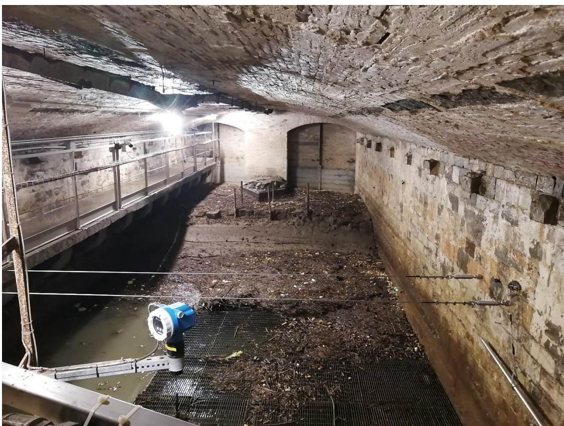
Foto n. 5 l'interno dell'opera di presa verso l'interno, sul fondo le tamponature incongrue dei canali da rimuovere
