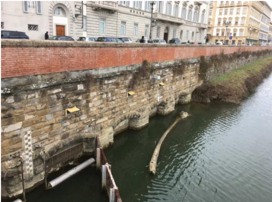
Foto n. 3 le bocche di presa sull'argine e la griglia paratronchi esistente in primo piano
