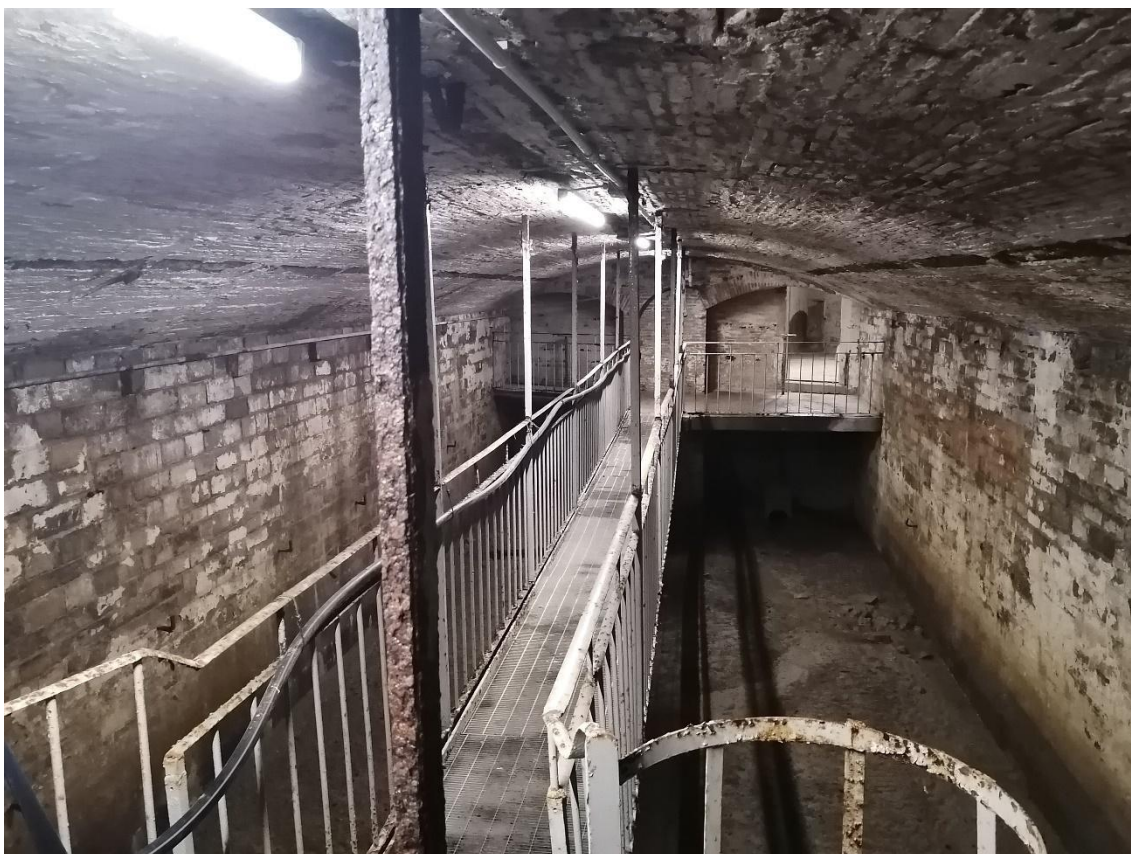
Foto n. 6 l'interno dell'opera di presa verso l'interno, sul fondo le tamponature incongrue dei canali da rimuovere
