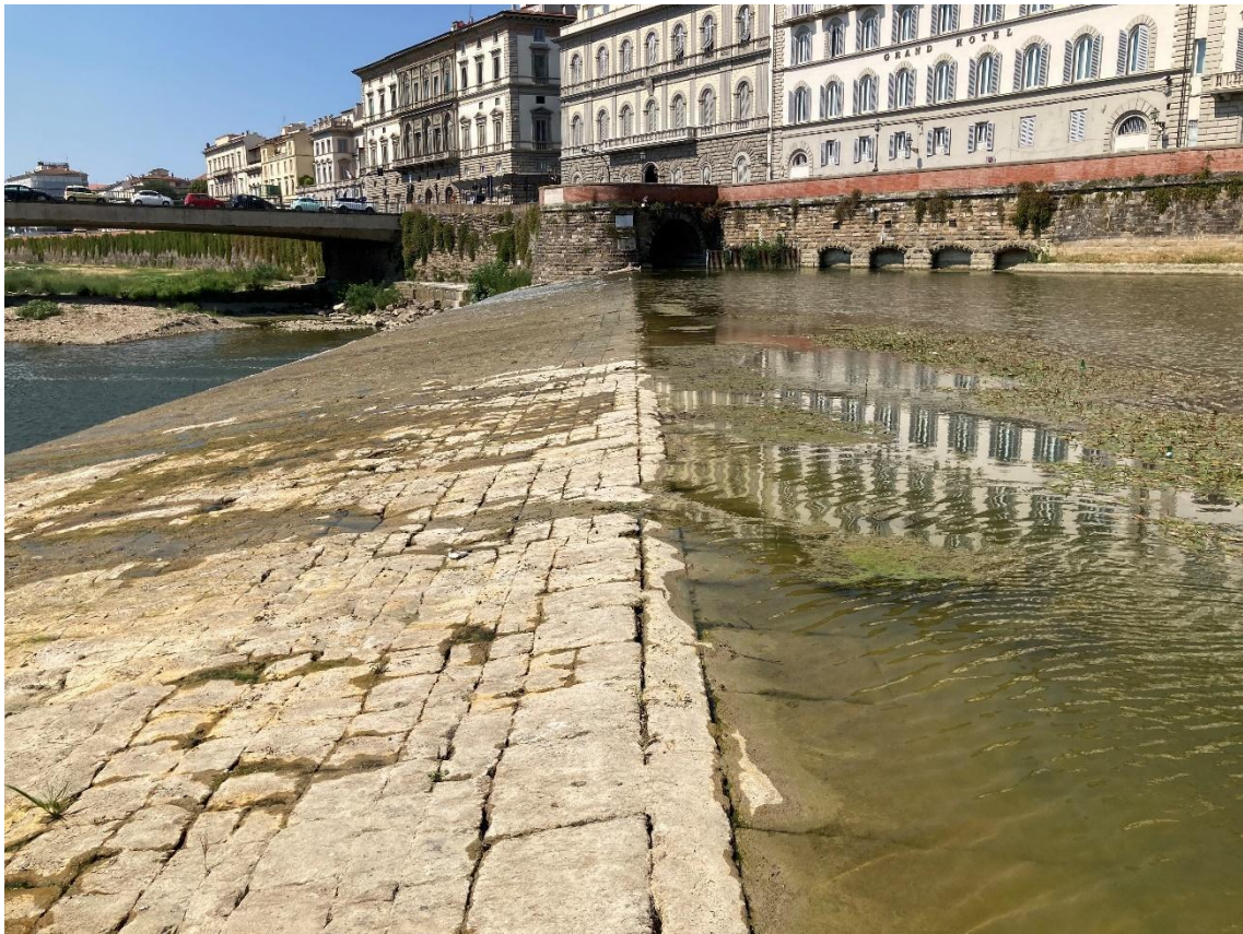
Foto n. 2 la briglia della Pescaia di Santa Rosa e le bocche di presa sull'argine
