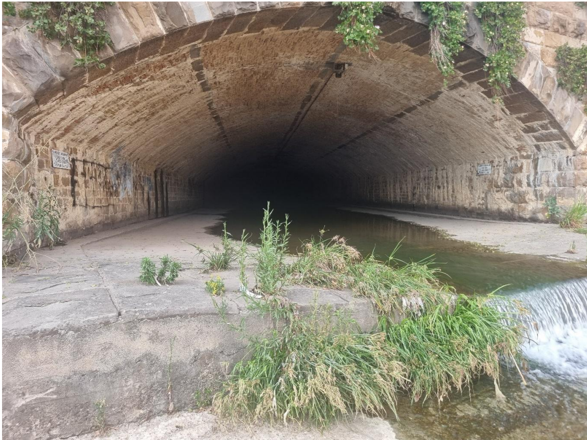
Foto n. 17_bocca del canale scolmatore sul fiume Arno
