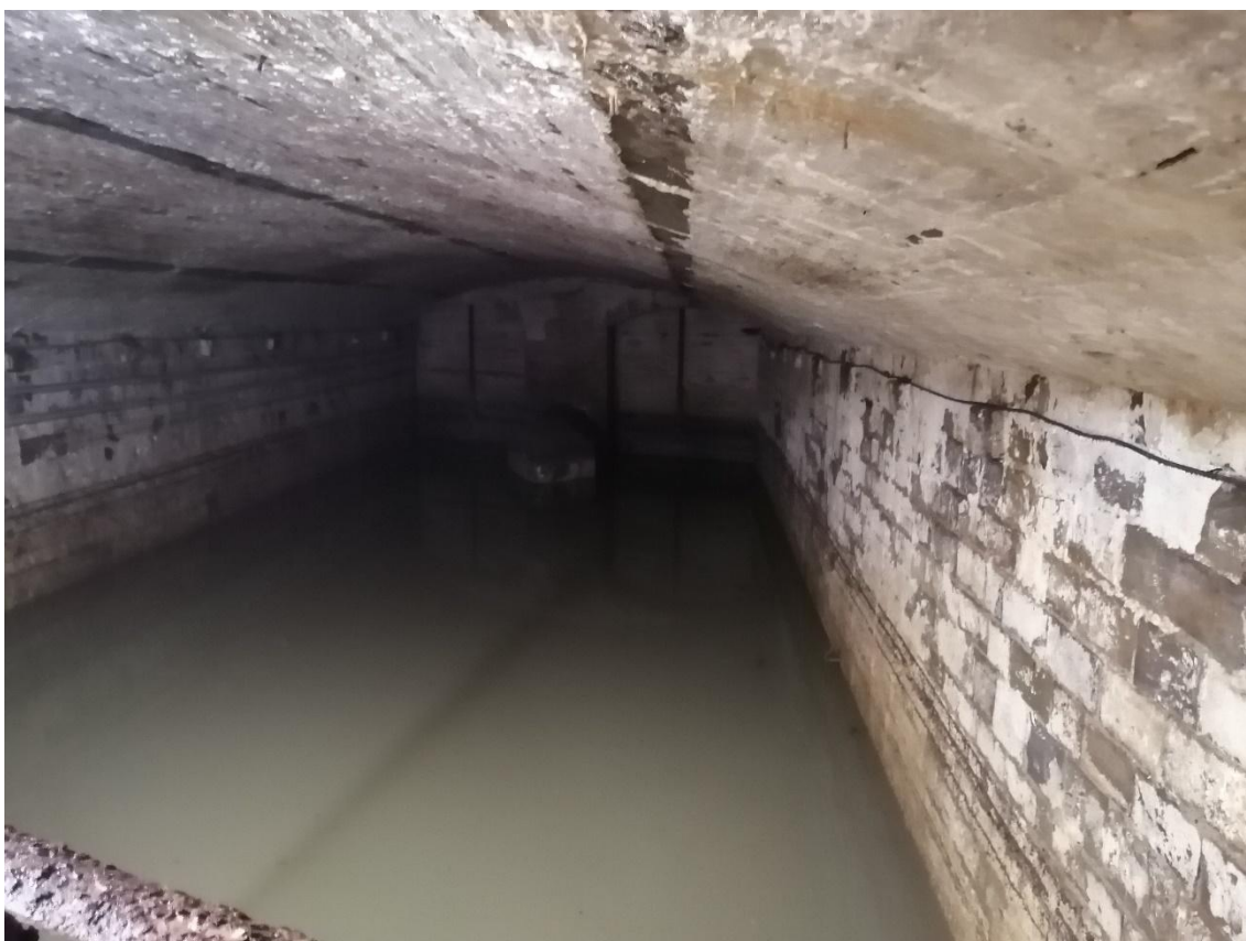
Foto n. 7 l'interno dell'opera di presa verso l'interno, sul fondo le tamponature incongrue dei canali da rimuovere
