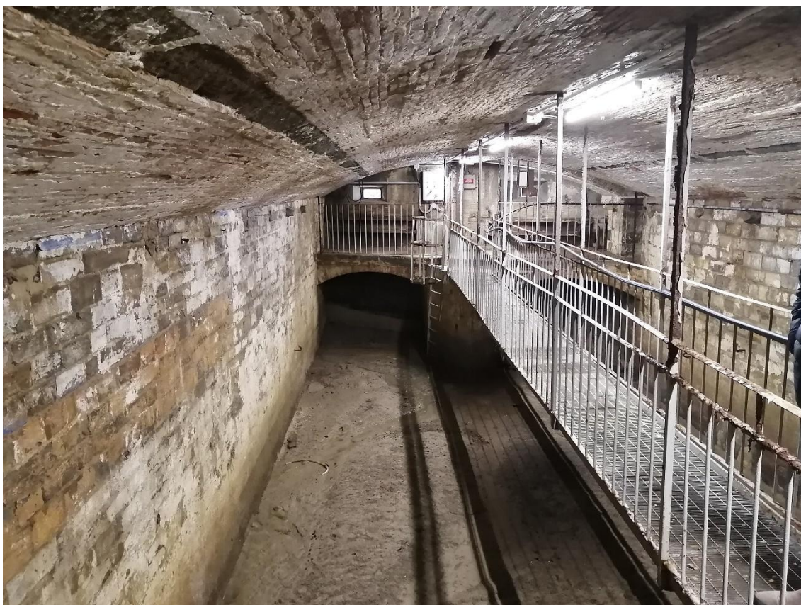
Foto n. 4 l'interno dell'opera di presa verso il fiume, sul fondo le tamponature incongrue delle bocche da rimuovere, a terra depositi da rimuovere
