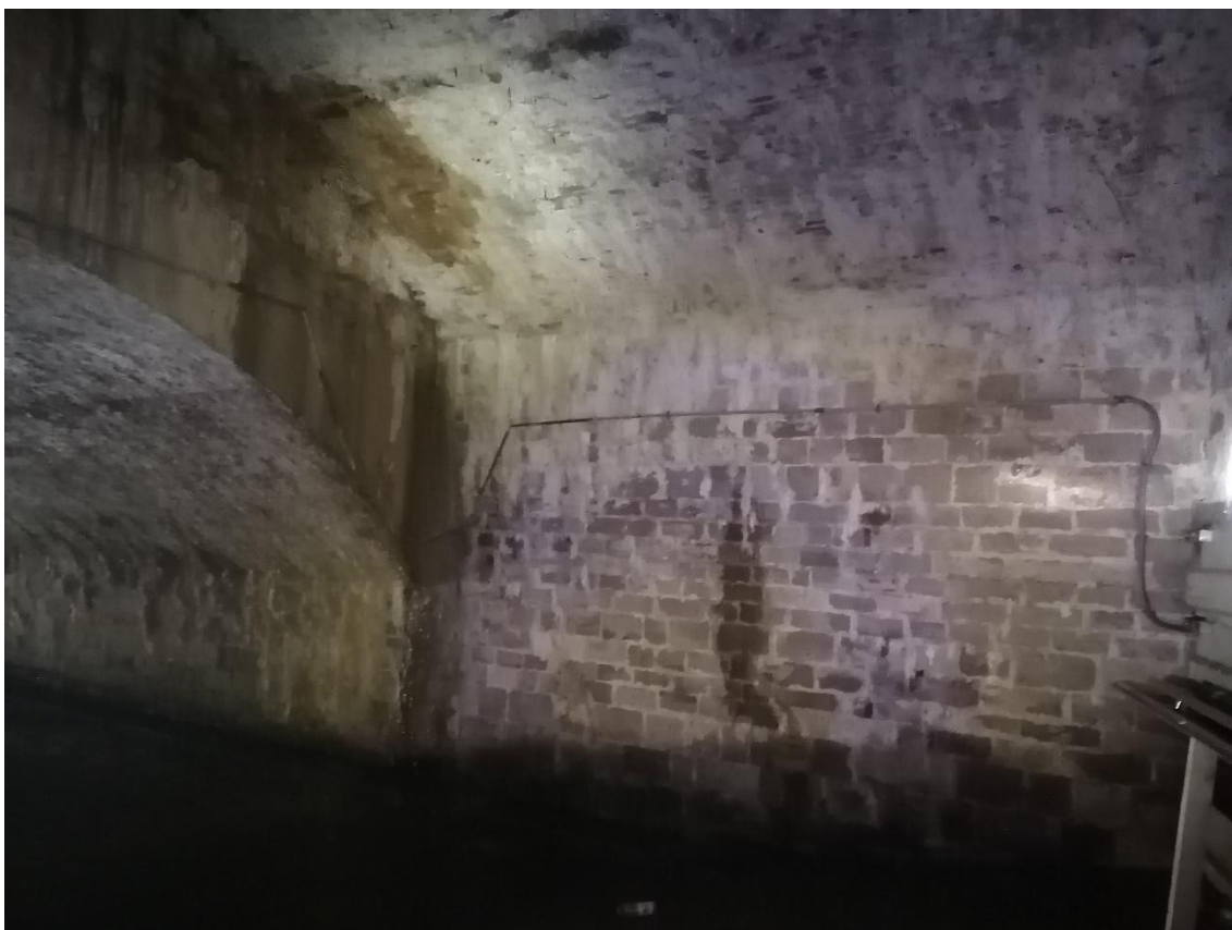
Foto n. 8 il canale scolmatore nel tratto in cui cambia altezza individuando il prolungamento di epoca recente
