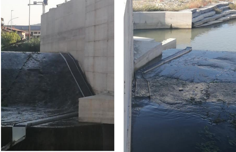
Esempio di scala per anguille
