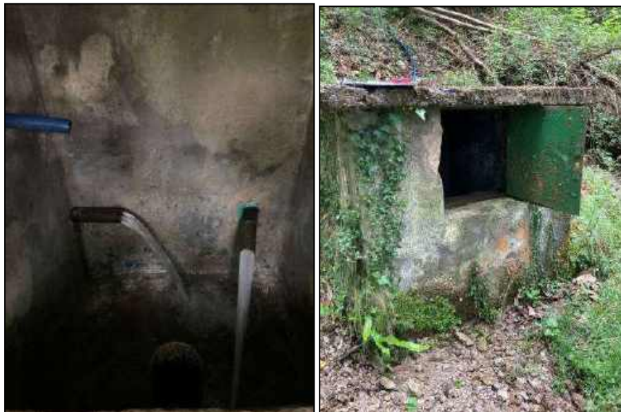
Figura 23: Vasca di raccordo sorgenti Boscacci 1 e 2
