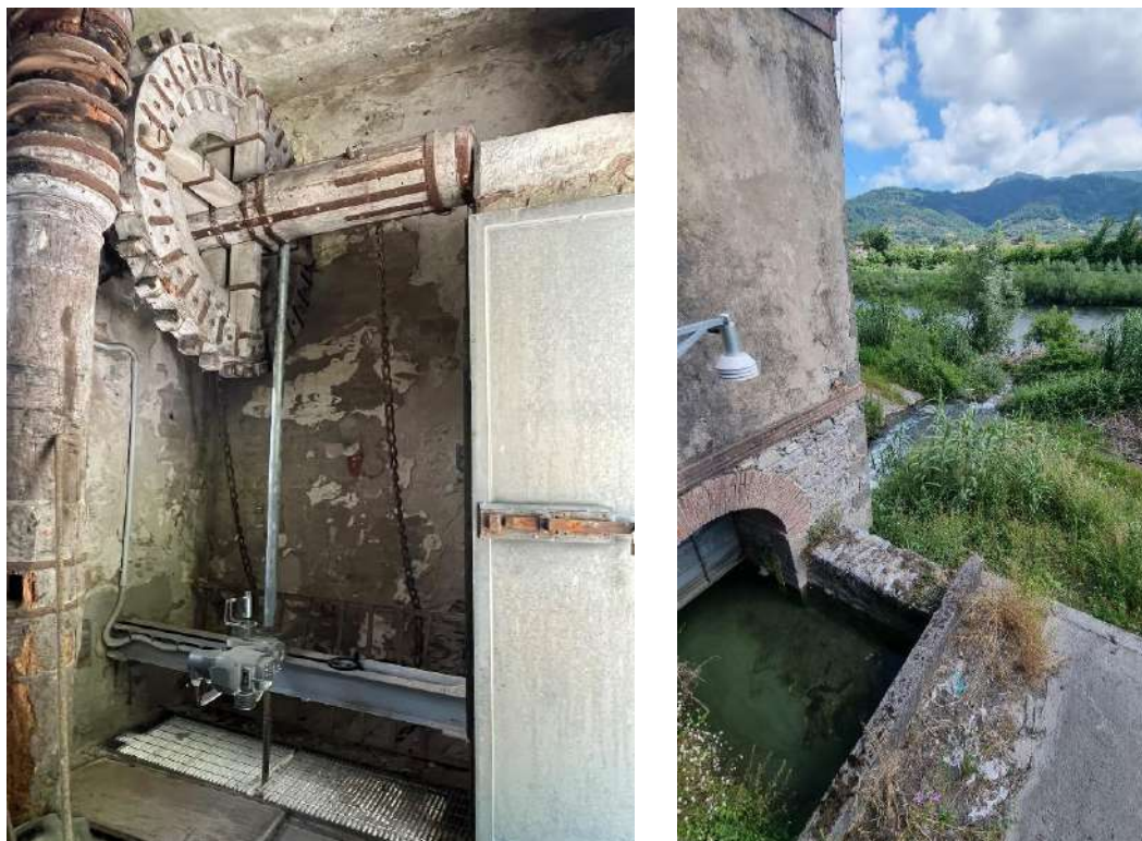
Figura 30 – A partire da sinistra: cataratta a vite manovrabile all'interno del casello idraulico; a destra in primo piano canale di Moriano alimentato dalla paratoia, al netto della restituzione, visibile sullo sfondo
