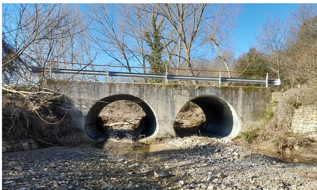
Figura 8: interferenza sul Torrente Rimaggio tra il corso d'acqua e la strada.
