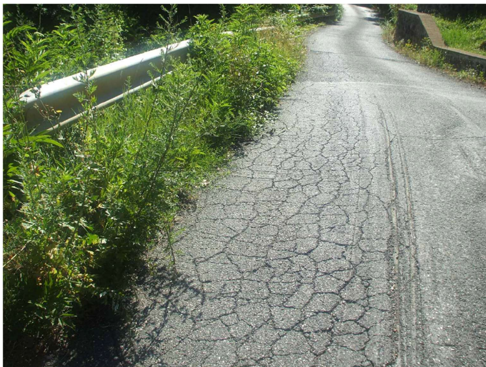
Figura 5 – Segni di fessurazione sulla strada esistente.
