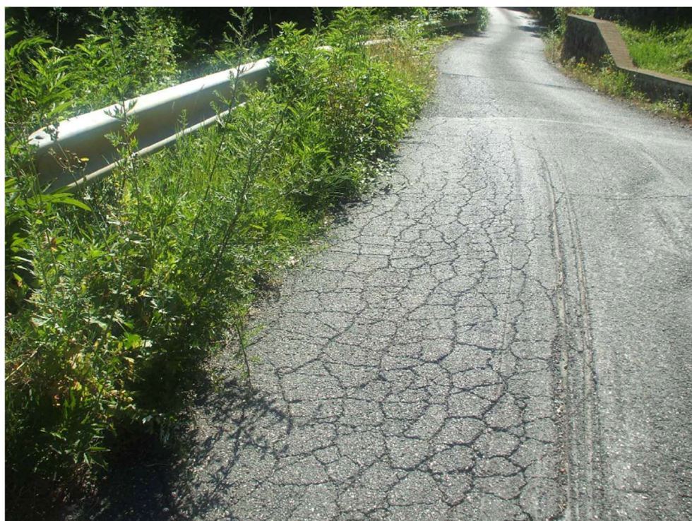
Figura 5 – Segni di fessurazione sulla strada esistente.
