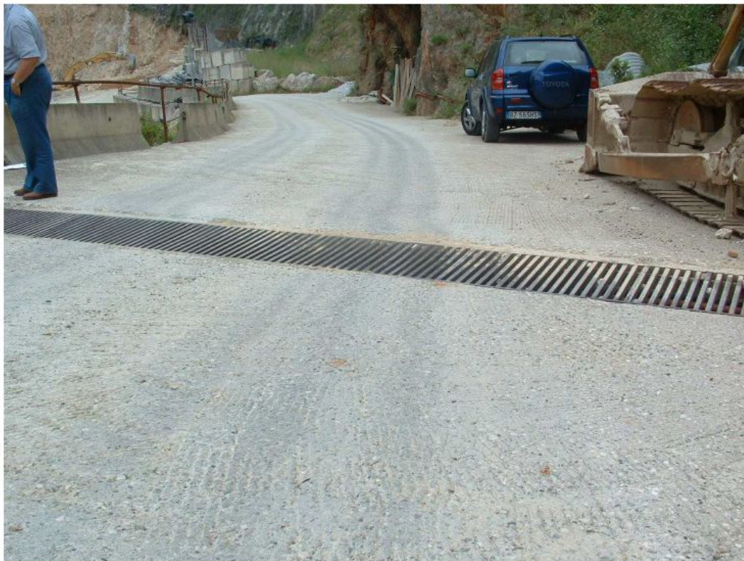
Foto n.2 Griglia a tutta strada realizzata su tutta la larghezza della carreggiata della viabilità d'arroccamento. Le acque intercettate vengono immesse all'interno di un pozzettone.
