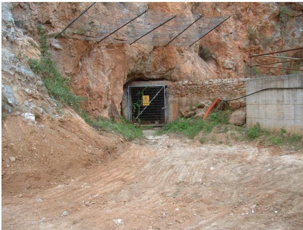
Foto n.4 Galleria dalla quale fuoriescono le acque di ruscellamento superficiale intercettate dalla griglia presente sulla viabilità d'arroccamento.
