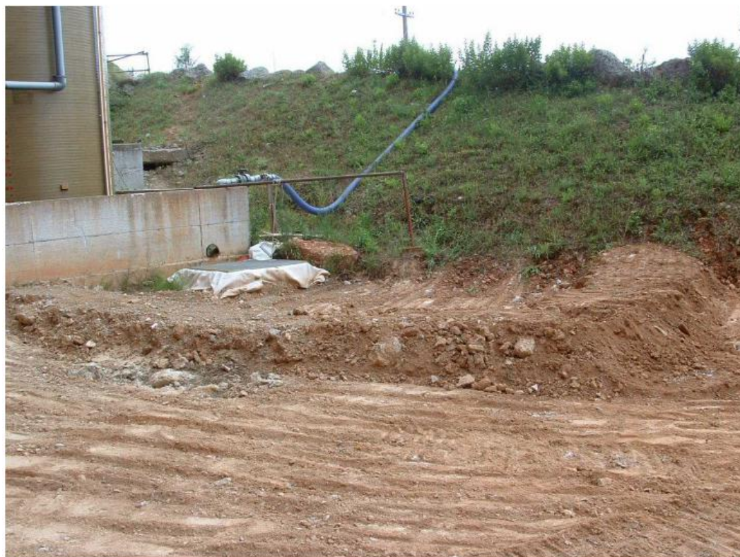
Foto n.6 Le acque decantate, una volta sormontato questo modesto argine, entrano nella griglia rivestita da tessuto-non tessuto visibile sullo sfondo. Da questa, tramite una pompa, vengono immesse all'interno della Fossa Fiorentina, in ritardo rispetto al picco di piena.
