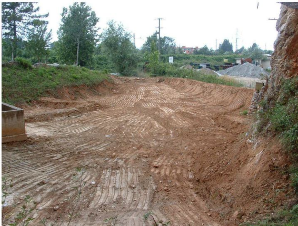
Foto n.5 Una volta fuori dalla galleria le acque ristagnano in questa "volumetria d'accumulo" nella quale hanno la possibilità di decantare.
