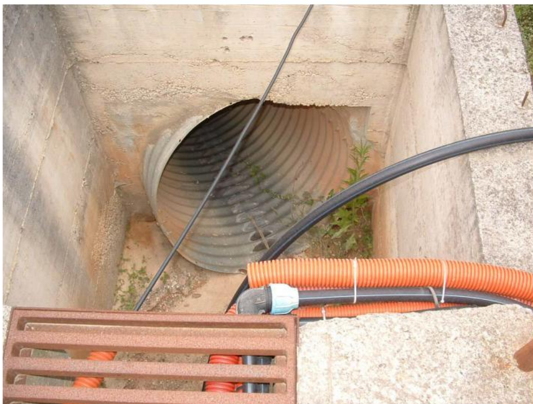
Foto n.3 Le acque intercettate dalla griglia entrano nel pozzettone e quindi all'interno della tubazione in finsider che le immette all'interno della galleria.
