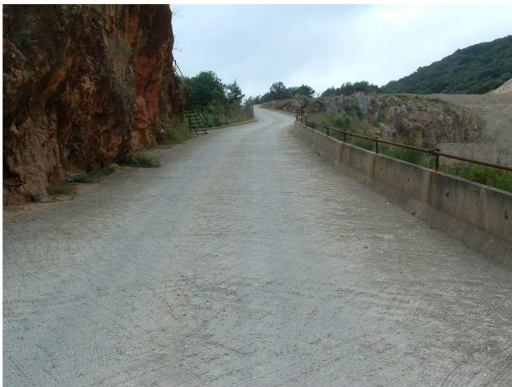
Foto n.1 Viabilità di arroccamento alla parte alta della discarica, a monte della griglia a tutta strada. La presenza dei cordoli impedisce alle acque di riversarsi lungo le scarpate.
