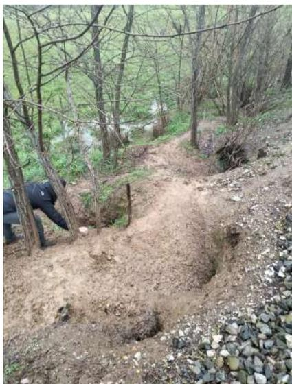
*Figura 1: Tane di istrice sulla scarpata ferroviaria*
