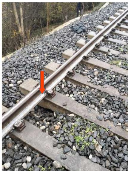
Figura 5: Avvallamento della massiciata causato dalle tane di istrice sottostanti
