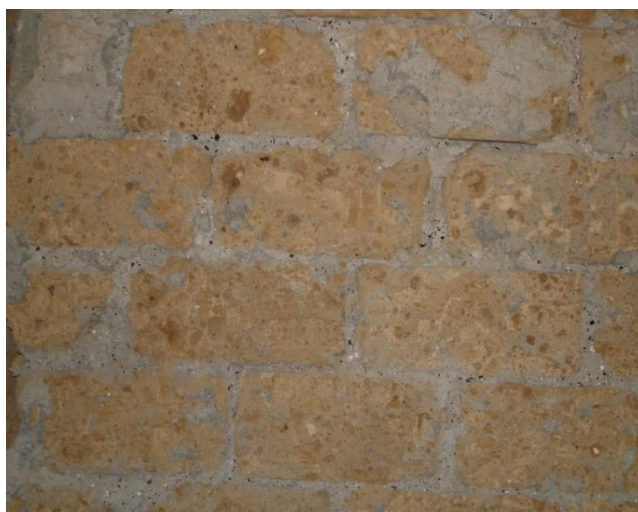
Figura 2: Muratura in tufo e malta buona (prova 023).
