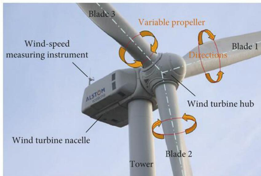
Figura 3 Operazioni attuate dalla turbina al segnale di stop
