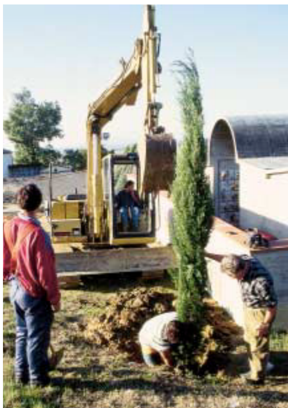
5. Impianto di cipresso della varietà “Bolgheri”, previa apertura di idonea buca
