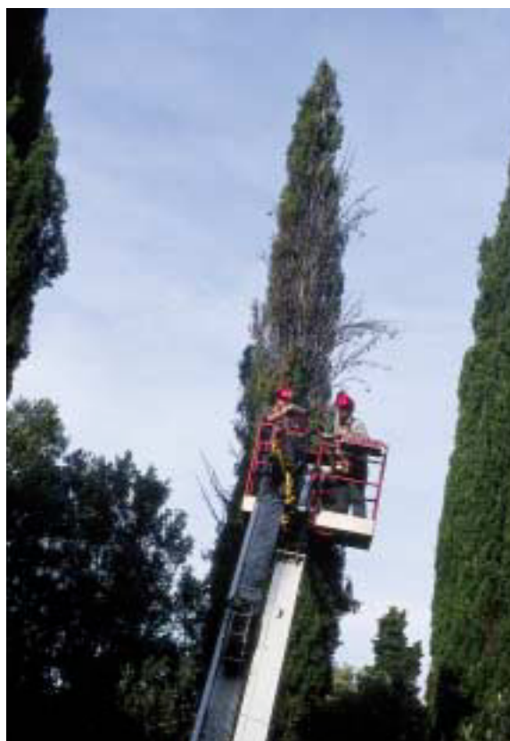
4. Esempi di intervento di risanamento con piattaforma aerea
