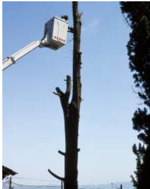
8. Abbattimento di imponente cipresso svettante su pubblica via e che non consentiva di agire altrimenti: progressiva depezzatura del fusto precedentemente sramato
