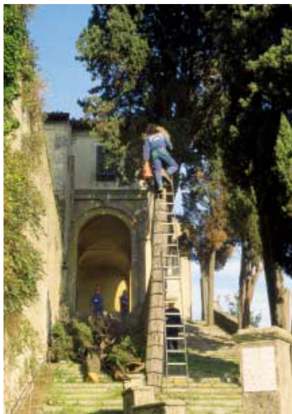
1. Operazioni di taglio, condotte con scala a mano, dove non è consentito l'accesso con mezzi meccanici
