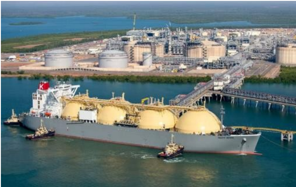
Figura 2: Deposito e rigassificazione di GNL in terraferma a Barcellona con nave gasiera in fase di carico/scarico
