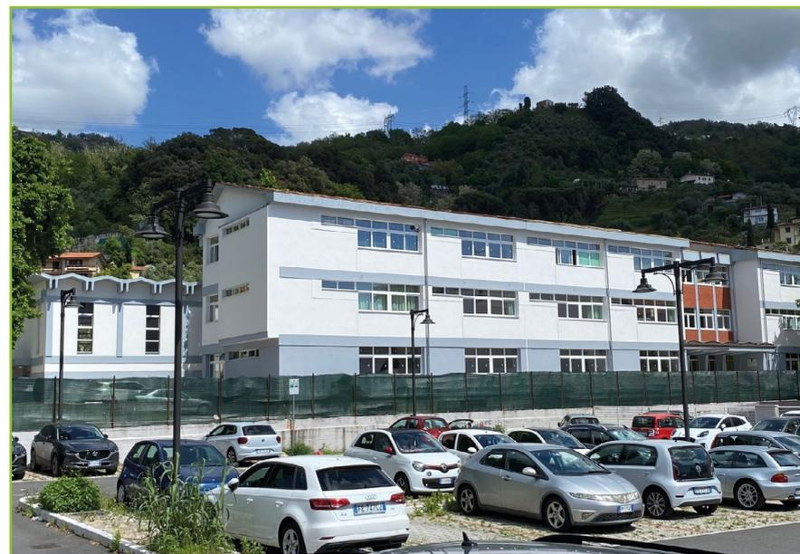
Attraverso l'intervento, presso la scuola Bertagnini sono stati realizzati lavori di efficientamento energetico dell'immobile, consistenti nella sostituzione degli infissi esistenti con infissi in PVC doppio vetro basso-emissivi, la realizzazione del cappotto esterno, la coibentazione della copertura, la sostituzione delle caldaie esistenti a gasolio con una a gas metano a condensazione e l'installazione di pannelli solari fotovoltaici.
