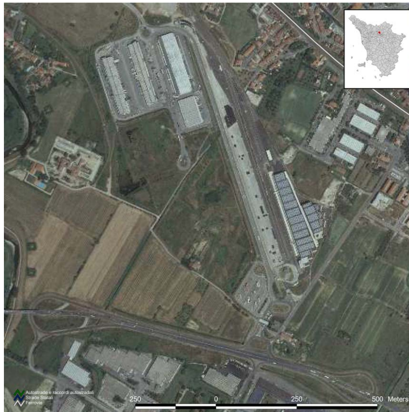
Figura 3.2 - Interporto Toscana Centrale (Prato)
