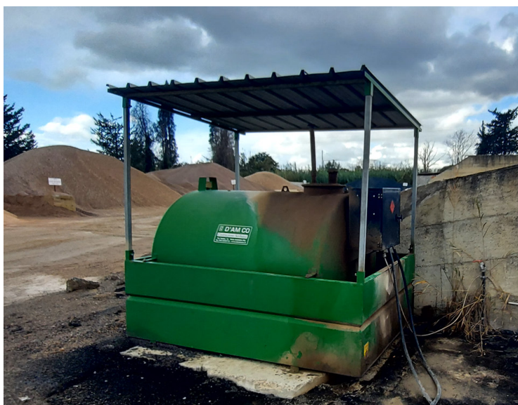
Foto 1 - Serbatoio Gasolio (3 mc) per alimentazione dei mezzi
