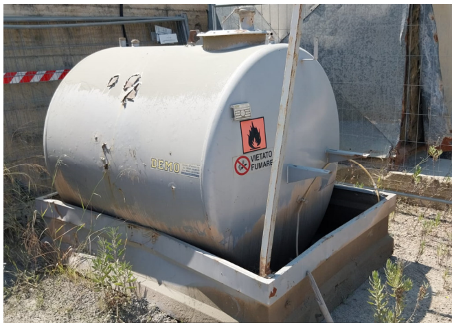
Foto 3 - Serbatoio Gasolio (2 mc)
