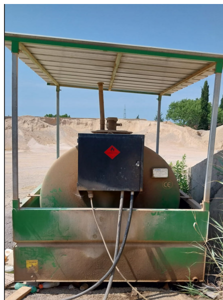
Foto 1 - Serbatoio Gasolio (3 mc) per alimentazione dei mezzi
