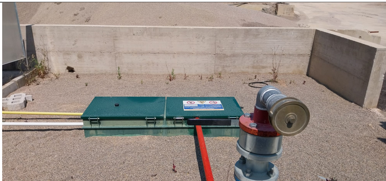
Foto 7 - Serbatoio GPL (interrato; 12,5 mc)
