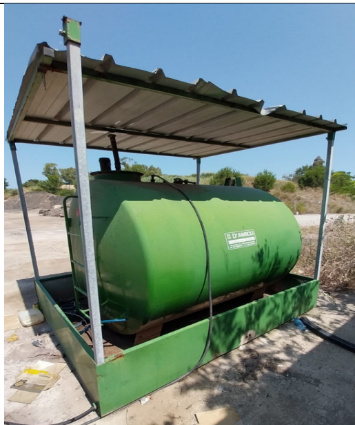
Foto 2 - Serbatoio Gasolio (5 mc) per alimentazione dei mezzi
