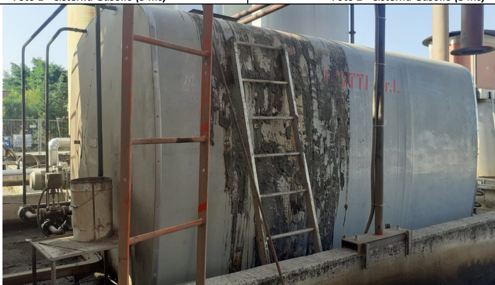
Foto 3 - Serbatoio Bitume (21 mc)
