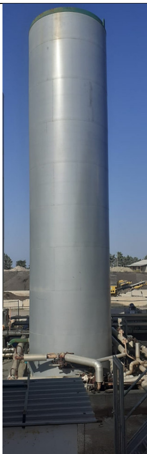
Foto 4 - Serbatoio Bitume (70 mc)
