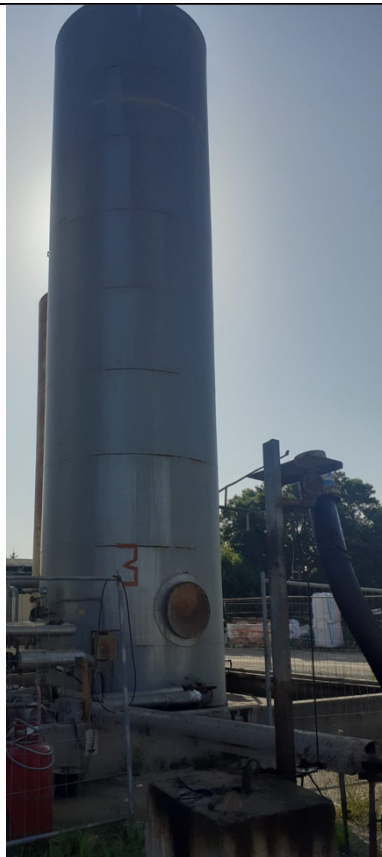
Foto 6 - Serbatoio Bitume (70 mc)
