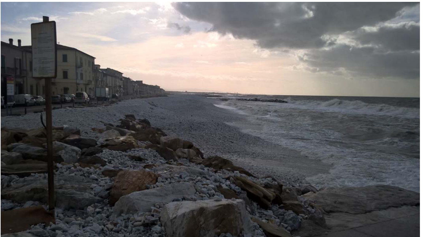
Vista verso sud della cella n. 4
