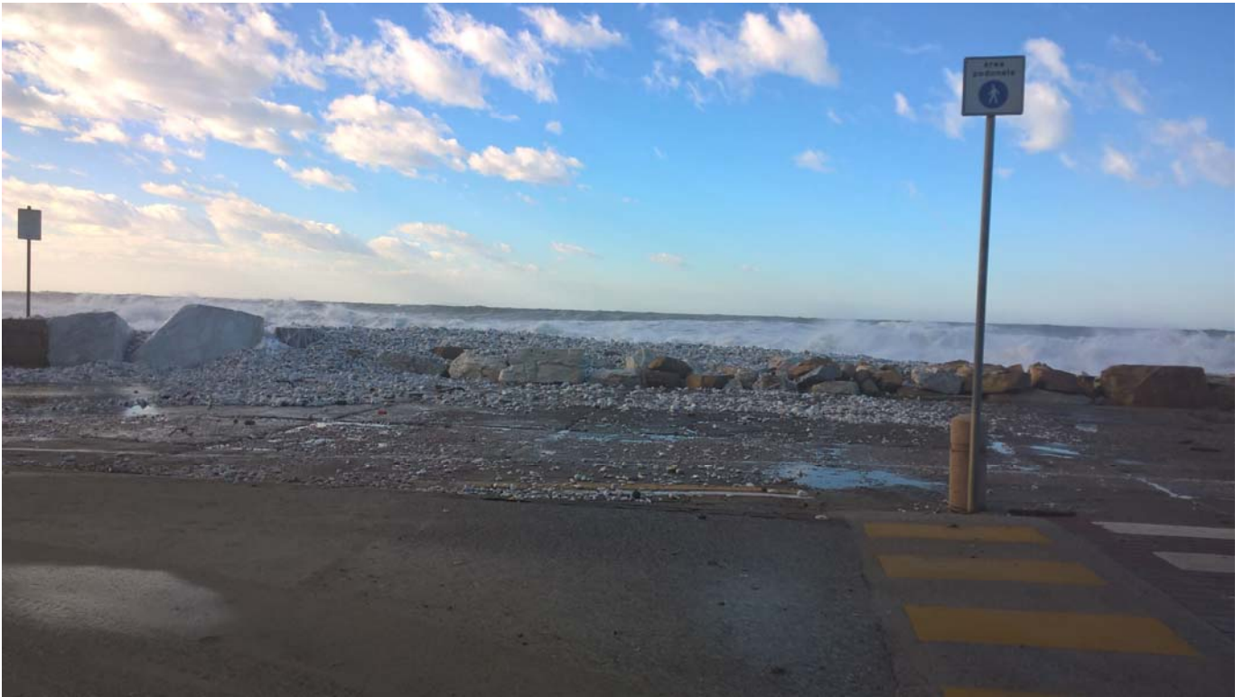
Vista porzione nord cella 4 (P.zza Baleari)
