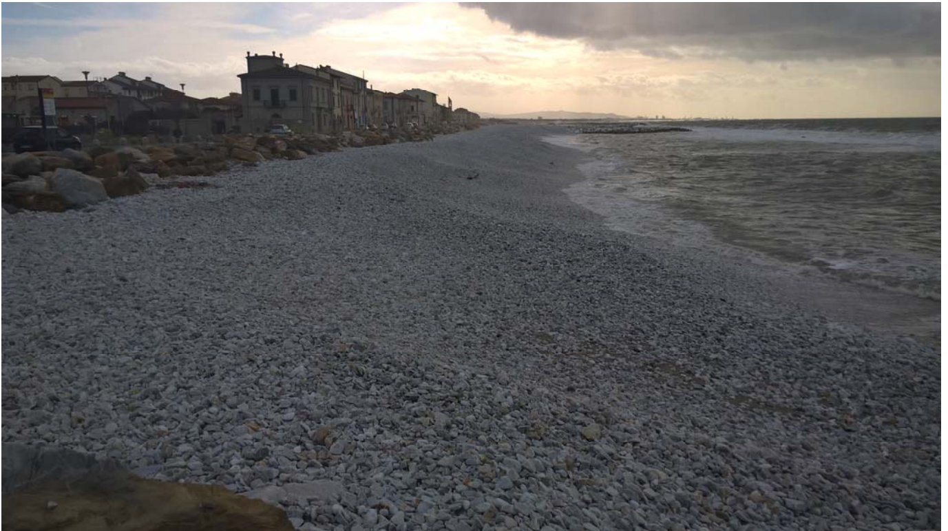
Vista verso sud della cella n. 6
