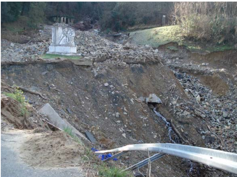
Figura 1.17 – (C) Erosione e cedimento a valle di Piazza XXV settembre
