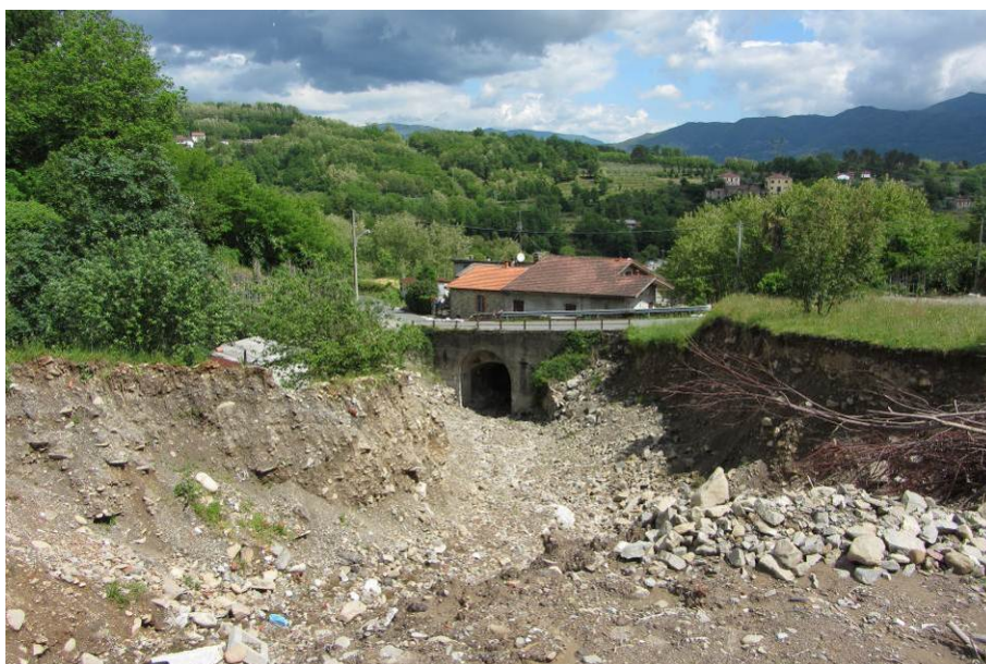
Figura 1.21 – (E3) Forte erosione a monte dell'abitazione edificata in alveo
