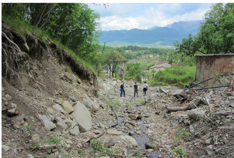
Figura 1.24 – (H) Erosione di sponda nella parte alta del Fosso della Madonna
