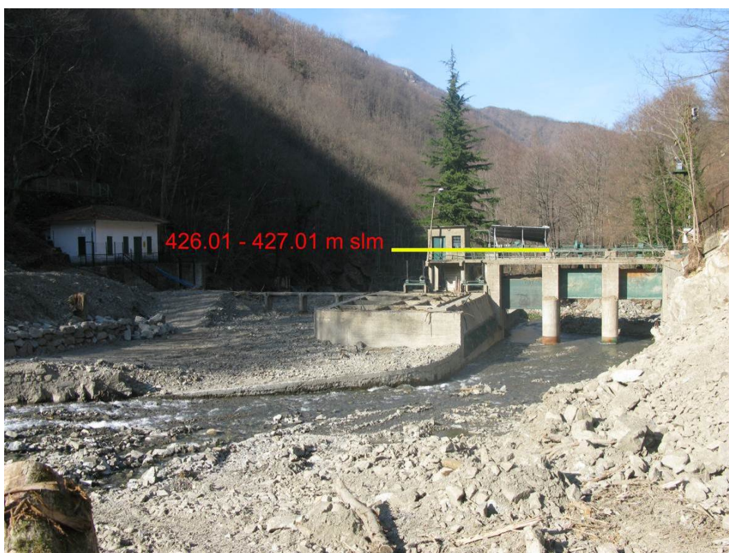
Figura 1.2 - Indicazione della traccia di piena T2, rilevata sul torrente Mangiola a valle dell'abitato di Montereaggio (Sezione 52A): il livello ha sommerso il volume in sommità all'opera di derivazione per un'altezza stimata variabile tra pochi centimetri ed 1 metro.
