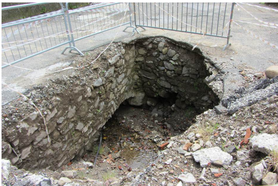
Figura 1.26 – (L) Rottura di un sottoattraversamento del Fosso di San Rocco
