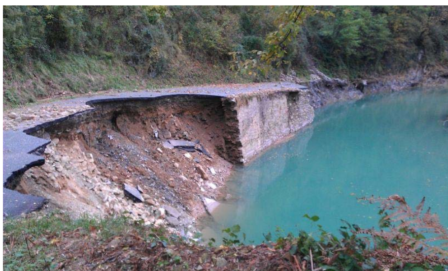
Figura 1.30 – (P) Crollo della SP n. 32 per erosione spondale in destra idraulica in prossimità della sezione n.56
