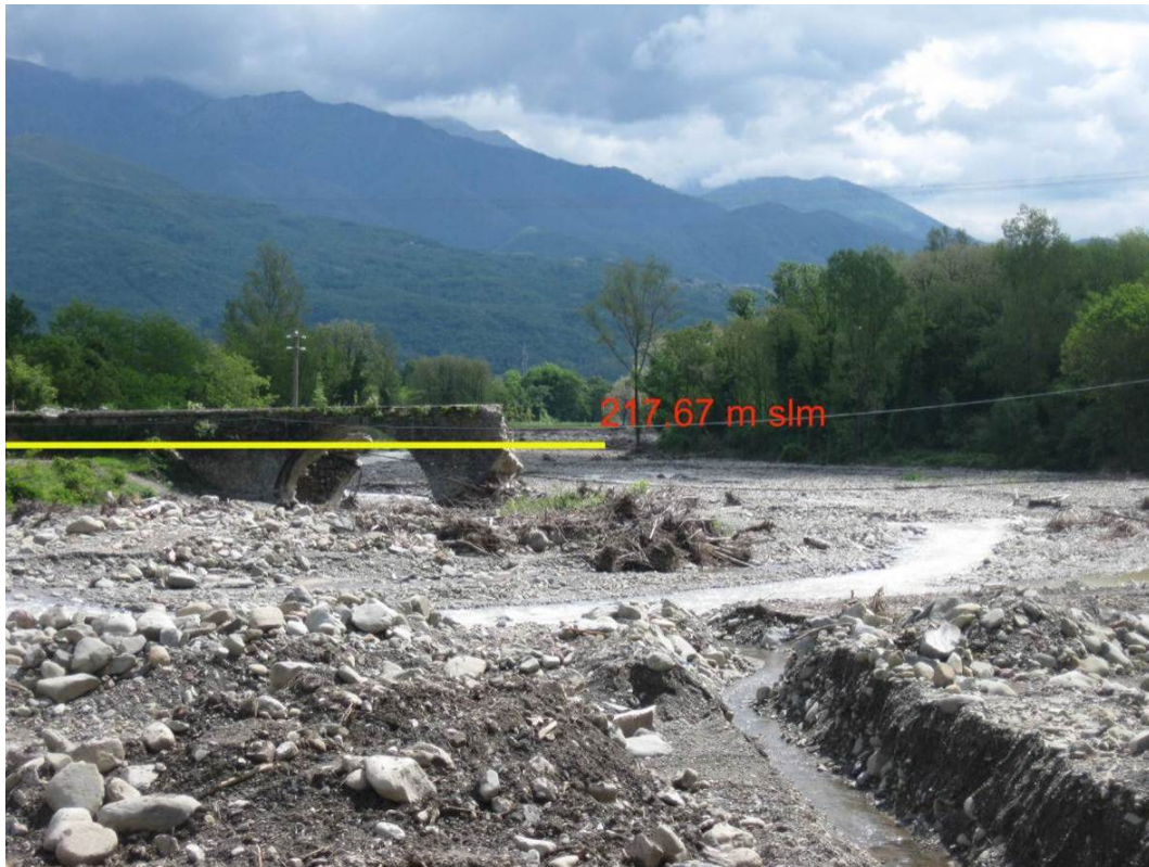
Figura 1.3- Indicazione della traccia di piena T3, rilevata sul torrente Mangiola in corrispondenza del ponte sulla viabilità per l'abitato di Mulazzo (Sezione 15): il livello ha sommerso l'area golenale in sinistra idraulica per circa 50 cm.
