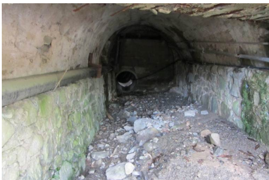
Figura 1.22- (F) Erosione in alveo e particolare di un sottoattraversamento della SP 32.
