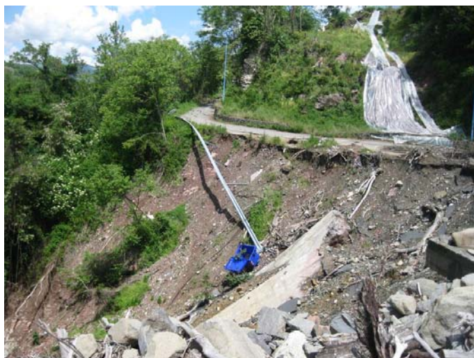
Figura 1.18 – (D) Erosione di versante e cedimento in Via Pirro Orlandini
