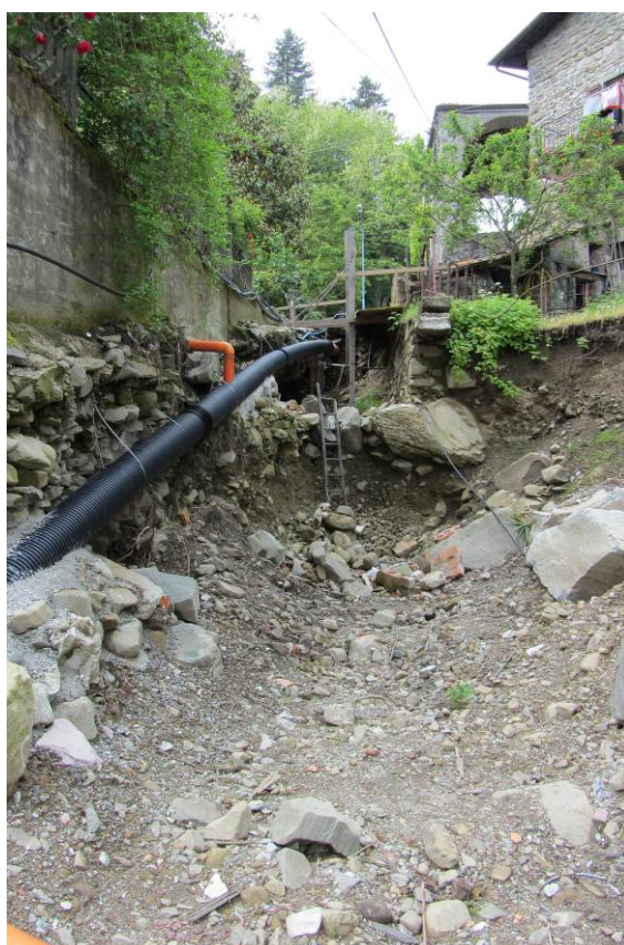
Figura 1.27 – (M) Fosso di San Rocco: erosione ed inondazione di abitazioni in sinistra idraulica a valle della chiesa di San Rocco
