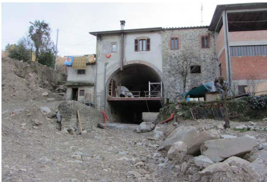
Figura 1.20 – (E2) Abitazione edificata in alveo. Il piano terra è stato sovralluvionato durante l'evento.
