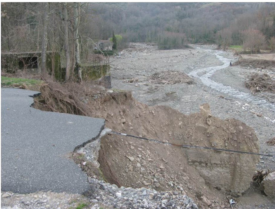
Figura 1.34 – (T) Erosione in destra idraulica in corrispondenza dell'appoggio del ponte sulla viabilità di collegamento per Mulazzo
