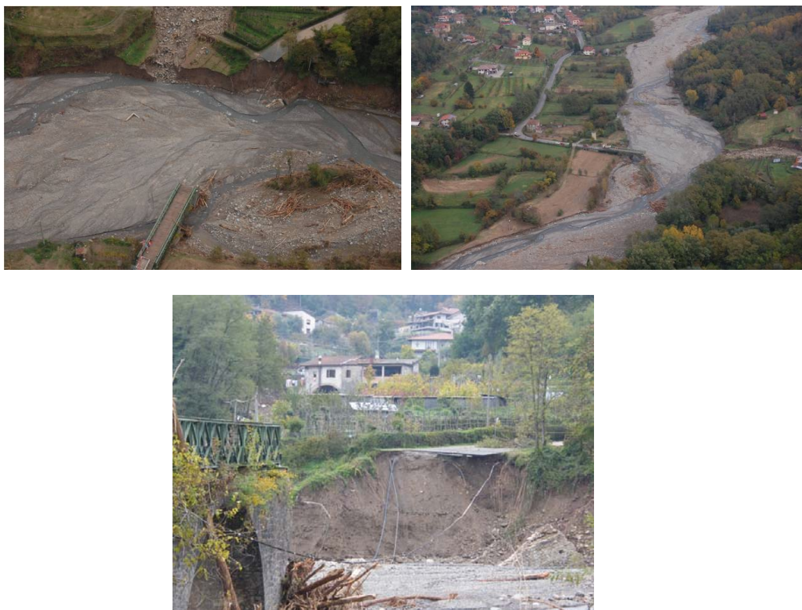
Figura 2.12 – Immagini del ponte sulla viabilità di collegamento per Mulazzo poco dopo il crollo.
