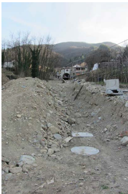
Figura 1.19 – (E1) Erosione d'alveo
