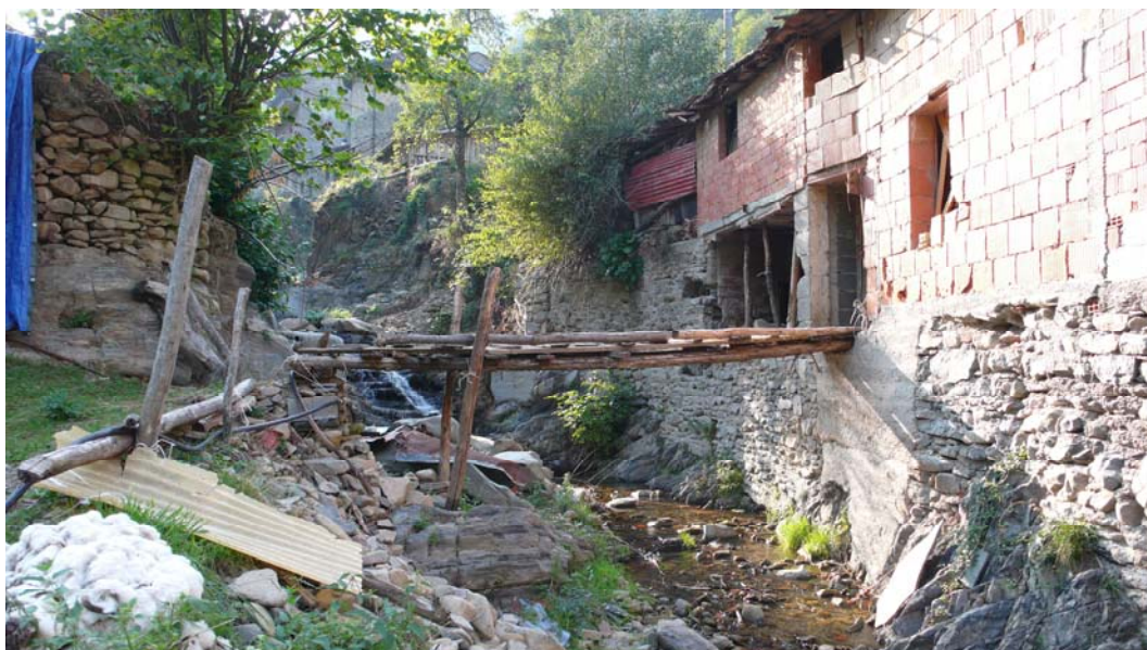
Figura 1. 29 Passerella provvisoria attualmente presente per consentire l'attraversamento del torrente (FOTO 9 in planimetria TGL 1.2)
