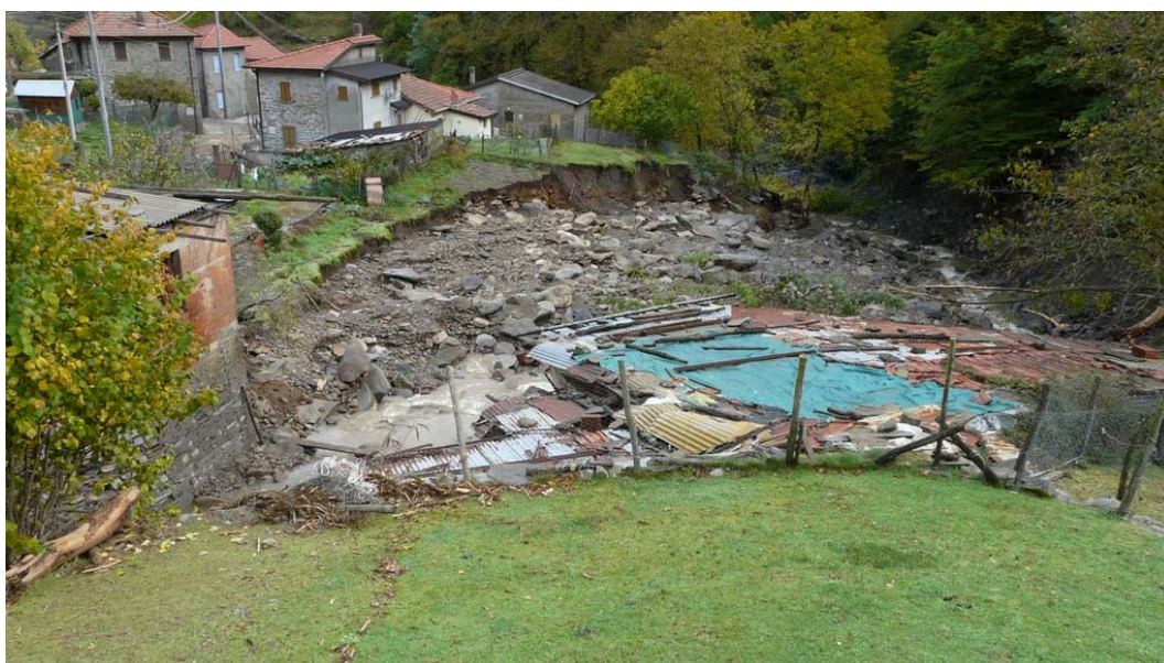
Figura 1. 30 Erosione in sinistra idraulica e deposito di grandi dimensioni (FOTO 10 in planimetria TGL 1.2)
