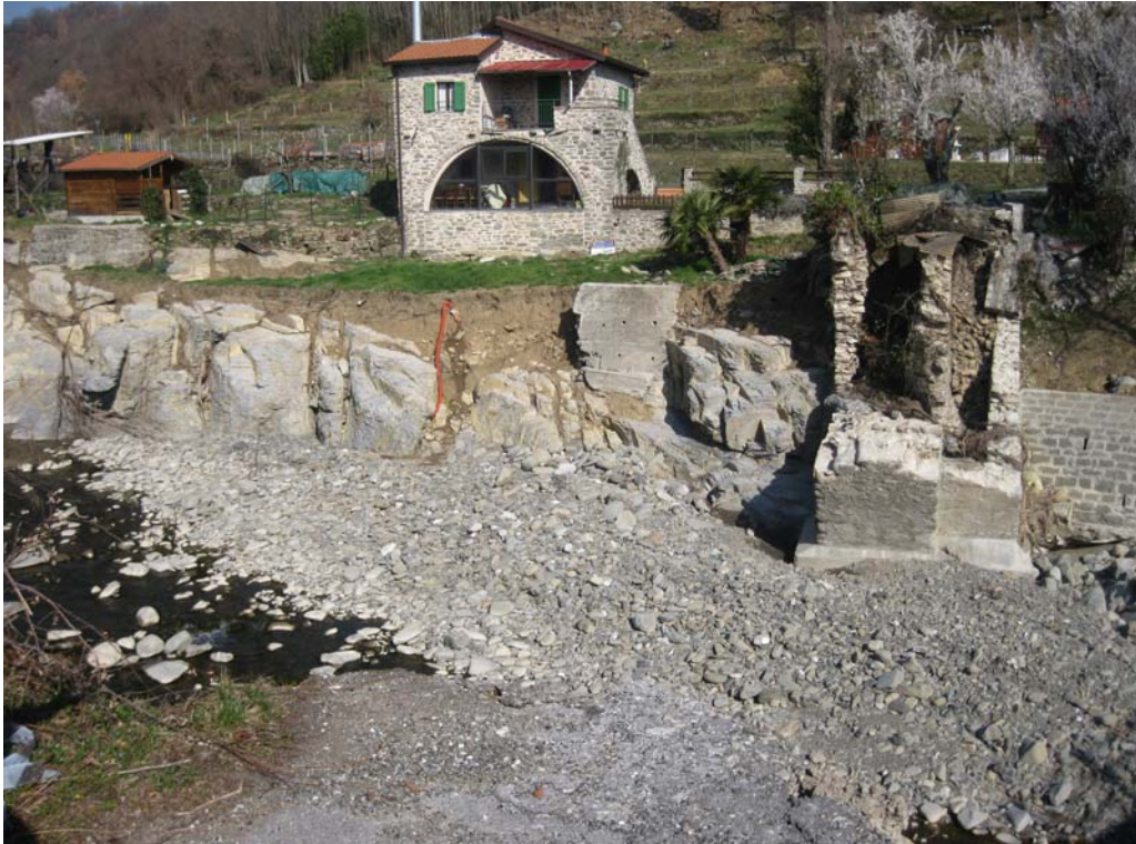
Figura 1. 19 Ponte Teglia: ponte crollato e erosione localizzata in sinistra idraulica (FOTO 5 in planimetria TGL 1.1)
