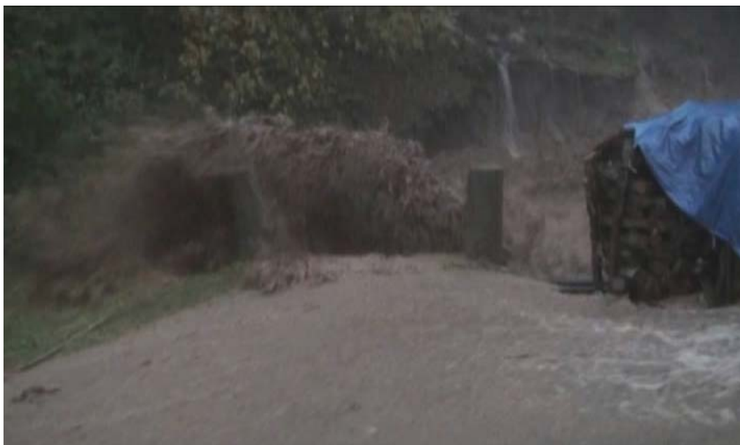
Figura 1. 67 Crollo del ponte (tra sezz. 5 e 6) durante l'evento alluvionale (FOTO 29 in planimetria TGL 1.2)
