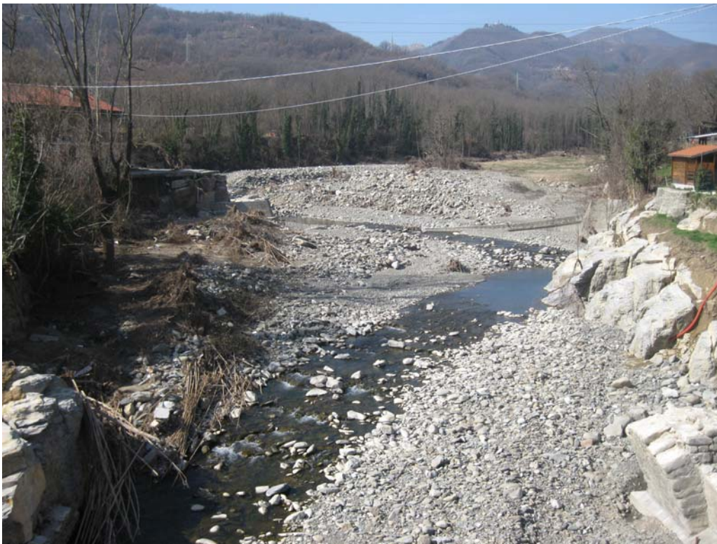
Figura 1. 20 Ponte Teglia: fenomeni erosivi localizzati in sinistra idraulica e deposito in alveo a monte del salto di fondo. (FOTO 6 in planimetria TGL 1.1)
