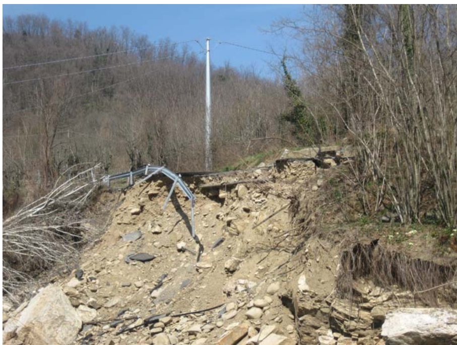
Figura 1. 23 Cedimento della SP 31 presso la località di Serola (FOTO 8 in planimetria TGL 1.1)
