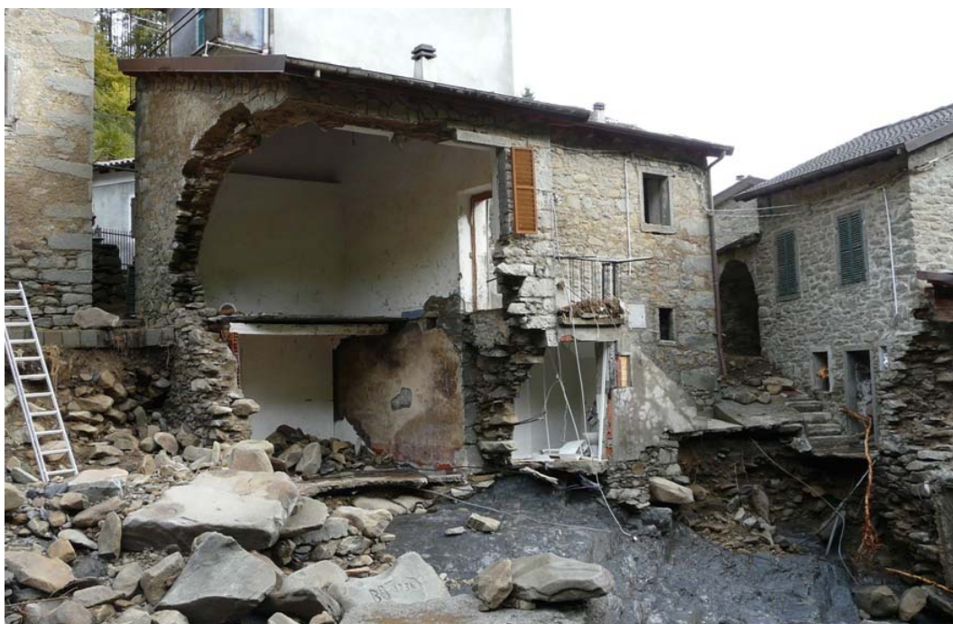
Figura 1. 33 Distruzione di fabbricati adiacenti al torrente (FOTO 5 in planimetria TGL 1.2)
