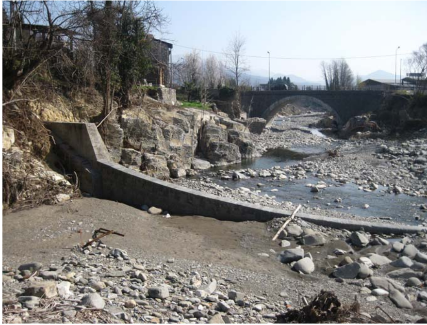
Figura 1. 21 Salto di fondo collocato a monte di Ponte Teglia (FOTO 1 in planimetria TGL 1.1)
