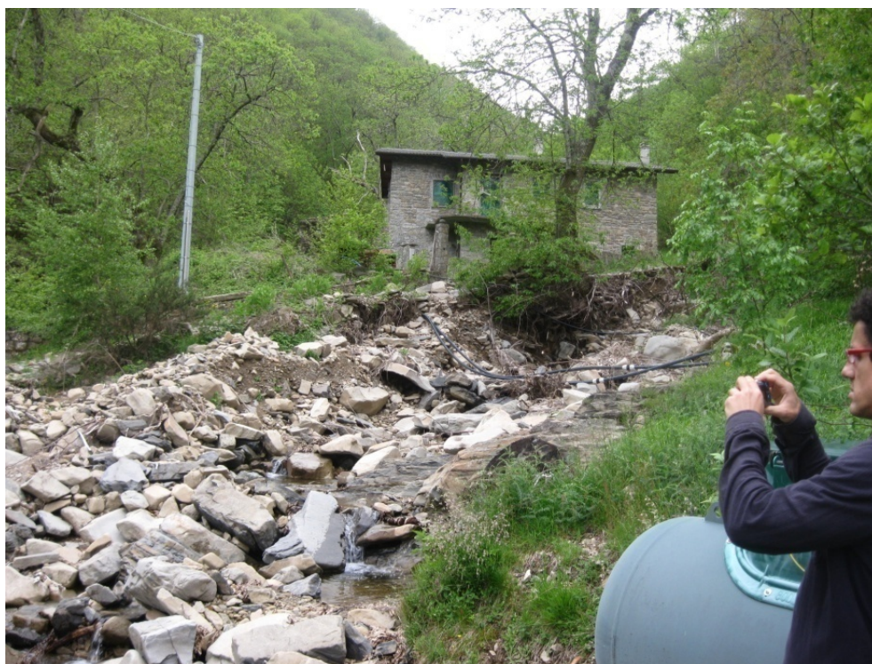
Figura 1. 40 Trasporto di materiale solido ad opera dell'affluente in sinistra idraulica del Canale del Bosco (FOTO 19 in planimetria TGL 1.2)
