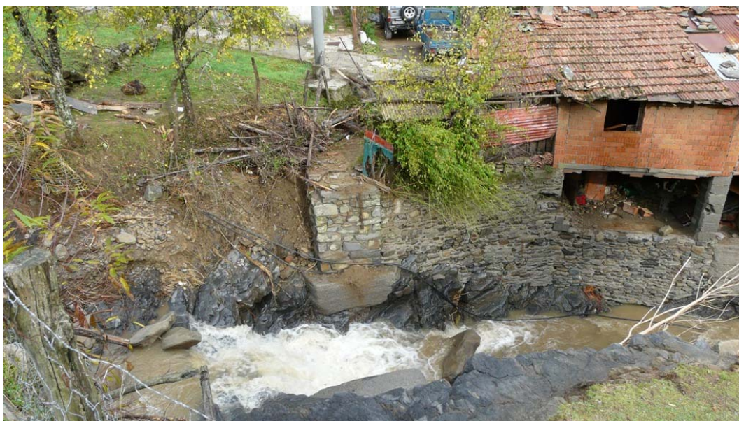
Figura 1. 28 Ponte crollato sul Canale del Bosco (FOTO 8 in planimetria TGL 1.2)
