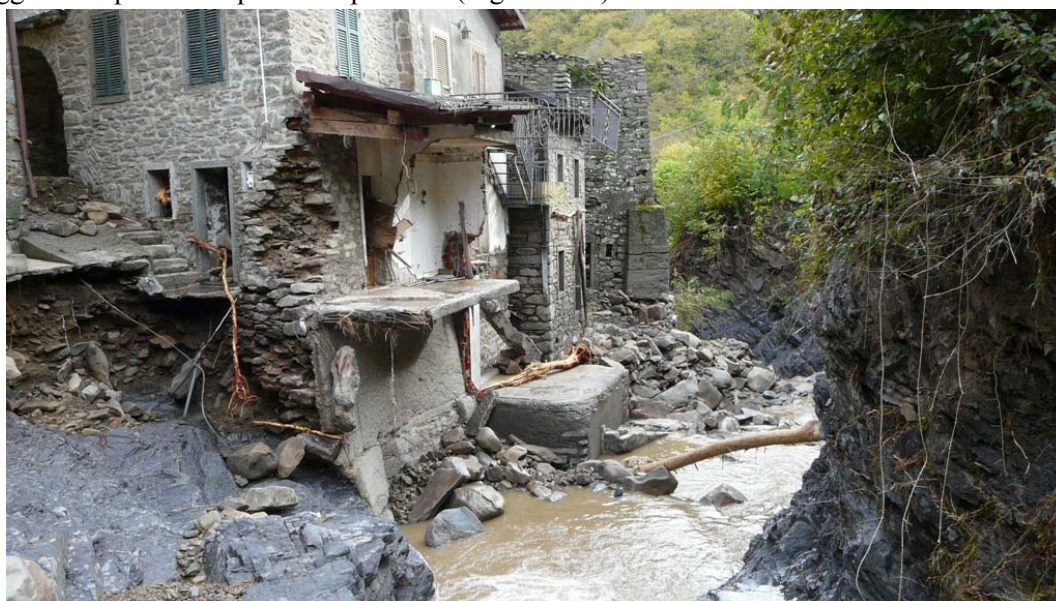
Figura 1. 32 Distruzione di fabbricati adiacenti al torrente (FOTO 12 in planimetria TGL 1.2)
