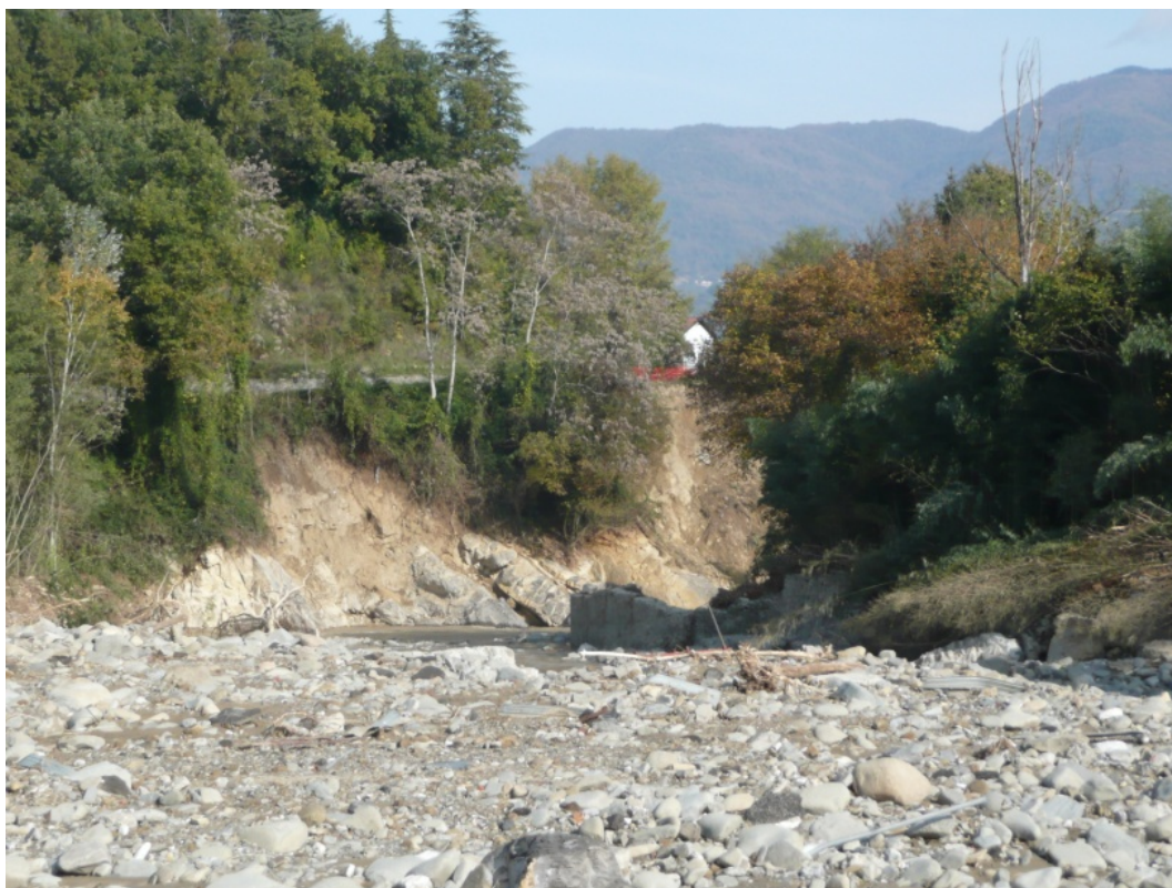
Figura 1. 17 Villa Pavese: erosione in sinistra idraulica e crollo di una parte della SP 31 (FOTO 4 in planimetria TGL 1.1)
