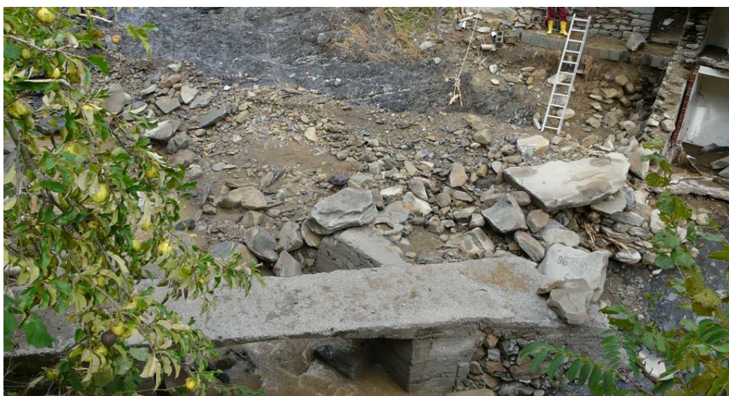
Figura 1. 34 Passerella aggirata dalla corrente (FOTO 13 in planimetria TGL 1.2)
