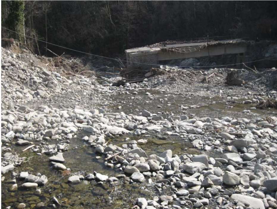
Figura 1. 24 Ponte sulla SP 31 crollato a seguito dell'evento (FOTO 9 in planimetria TGL 1.1)
