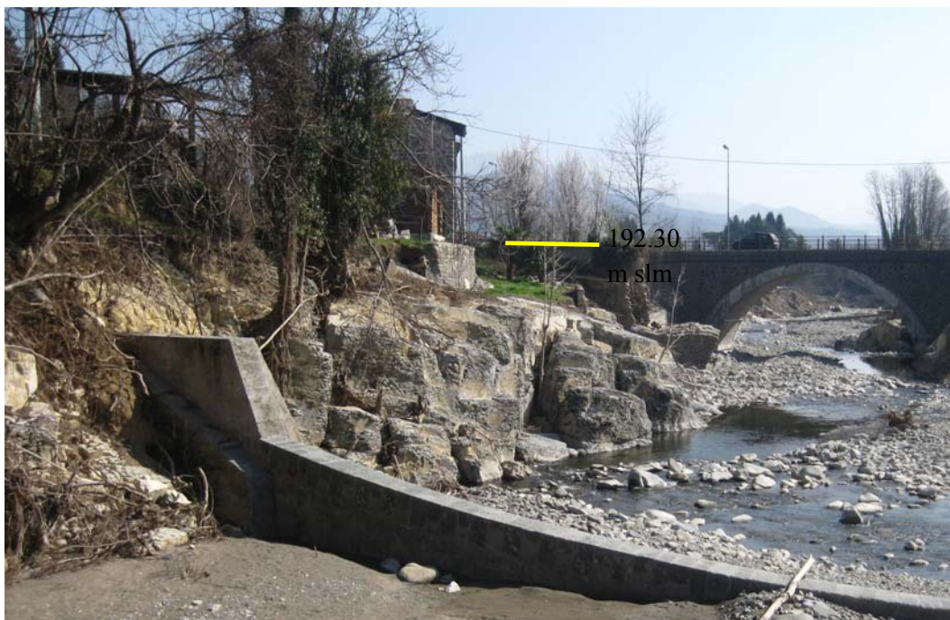
Figura 1. 1 Indicazione della traccia di piena rilevata a Ponte Teglia (Sezione 24): il livello ha raggiunto la quota del parapetto della finestra indicata nella foto. (FOTO 1 in planimetria TGL 1.1)
