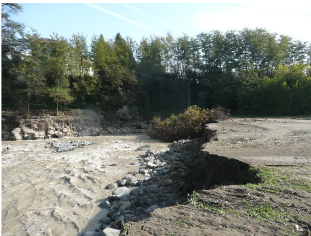
Figura 1. 16 Villa Pavesi: erosione in destra idraulica (FOTO 3 in planimetria TGL 1.1)
