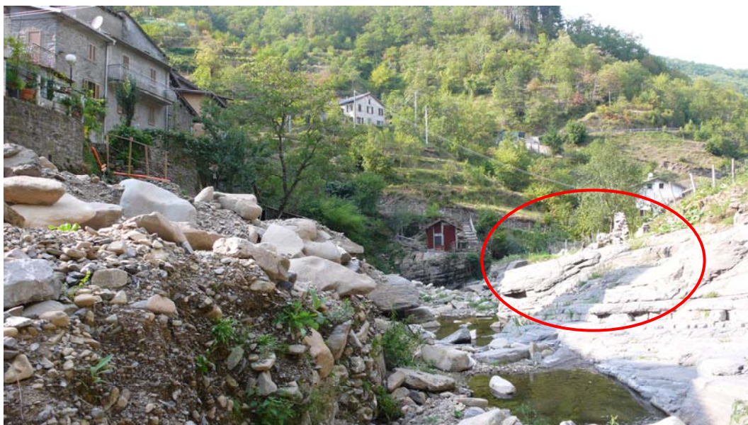
Figura 1. 64 Passerella distrutta e resti del mulino in destra idraulica sul Canale del Bosco (tra sezione 4 e sezione 5) dopo l'evento alluvionale (foto da monte) (FOTO 27 in planimetria TGL 1.2)
