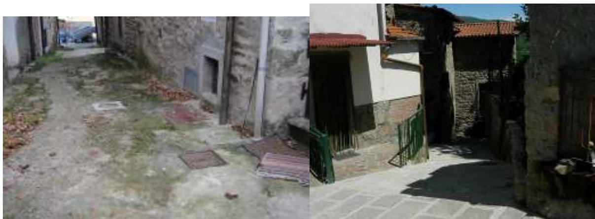
**Comune di Castiglion Fibocchi:** L'intervento ha previsto la riqualificazione del piccolo borgo di Gello Biscardo attraverso il rifacimento di un tratto di muro a sostegno di scarpata, steccionate di legno e ringhiere in ferro e pavimentazione di un tratto interno del borgo.
