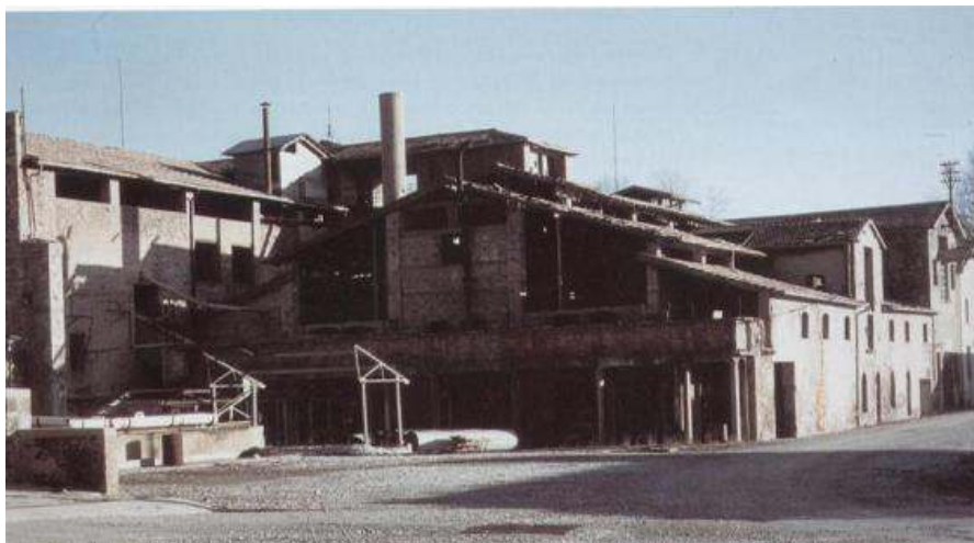
IL COMPLESSO PRODUTTIVO CHE INTERESSAVA L'AREA DI INTERVENTO PRIMA DELLA DEMOLIZIONE (ANNI '60)
