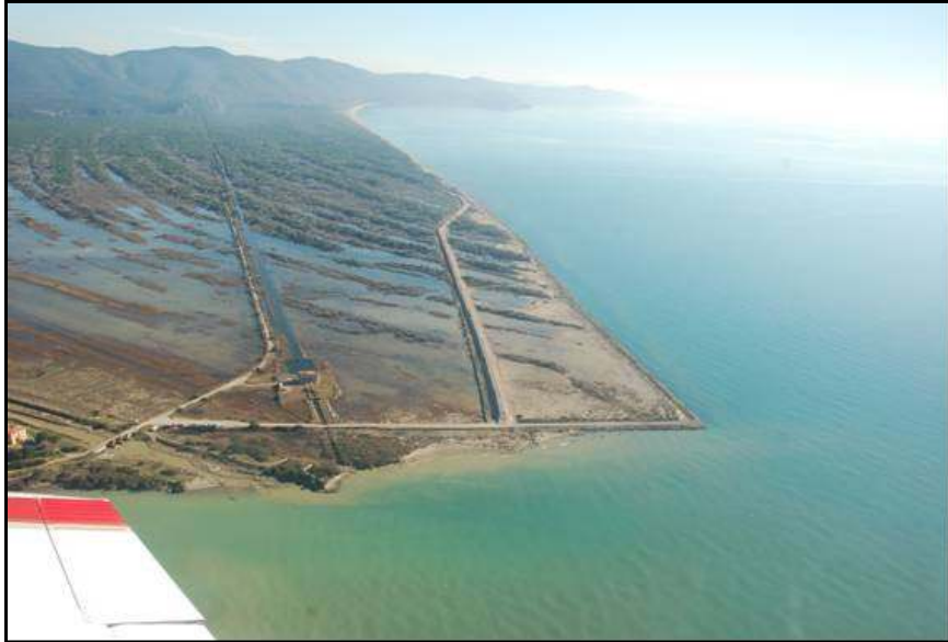
VISIONE D'INSIEME DELL'ASSETTO FINALE DELL'AREA DI INTERVENTO
