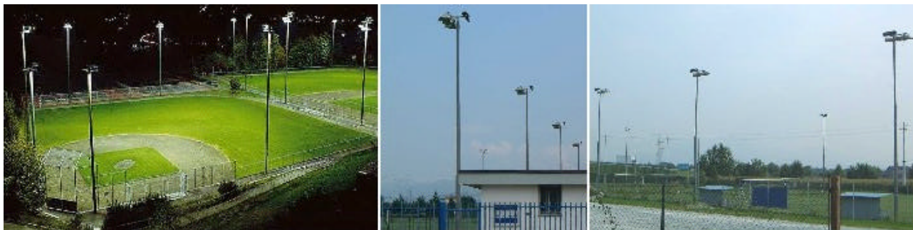
Figura 21 - Esempi di corretta illuminazione di impianti sportivi di piccole e medie dimensioni
