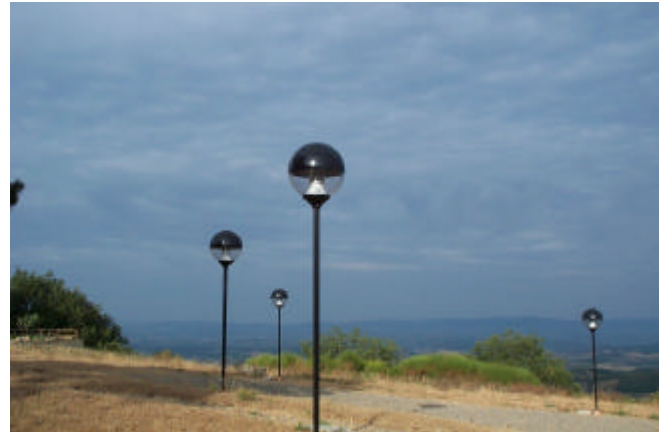
Figura 28 - Impianto con diffusori a sfere prima e dopo l'intervento di adeguamento. E' comunque vietato utilizzare questo tipo di corpi illuminanti per la realizzazione di un nuovo impianto.
