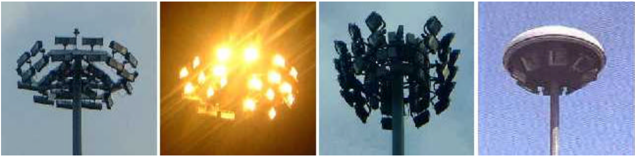
Figura 17 - Torri faro non schermate, quindi non conforme alla L.R. n°37/2000.
