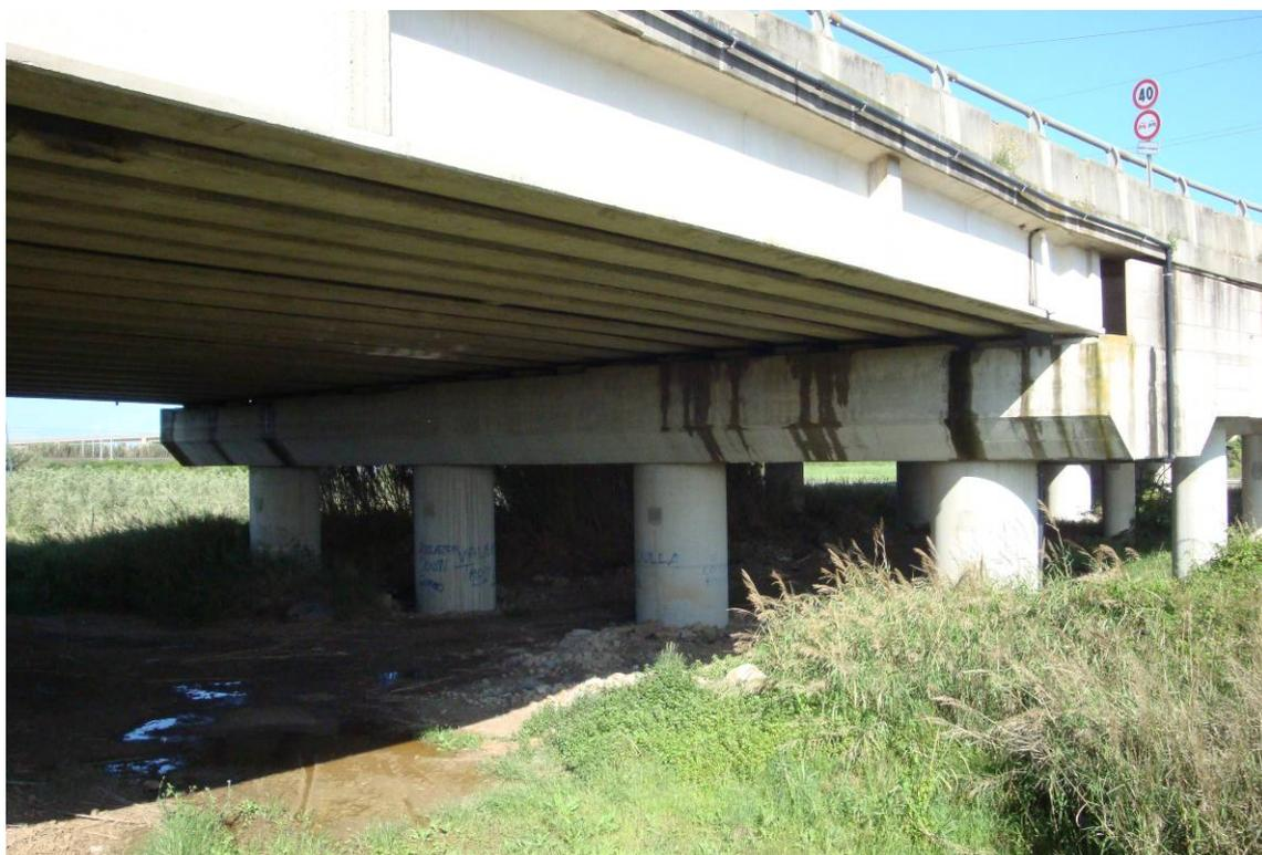
*Foto 13 – Particolare pila con 4 colonne, sull'innesto della rampa; scolature*
