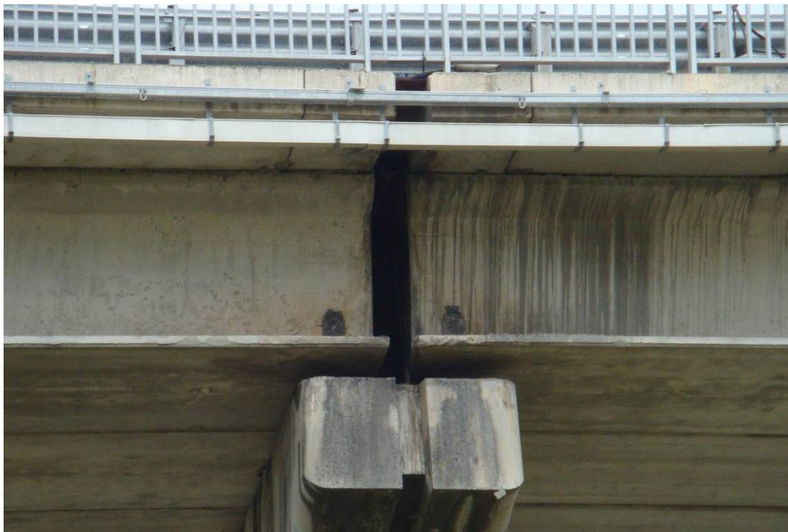
*Foto 9 – Vista giunto - particolare degrado travi e pila*
