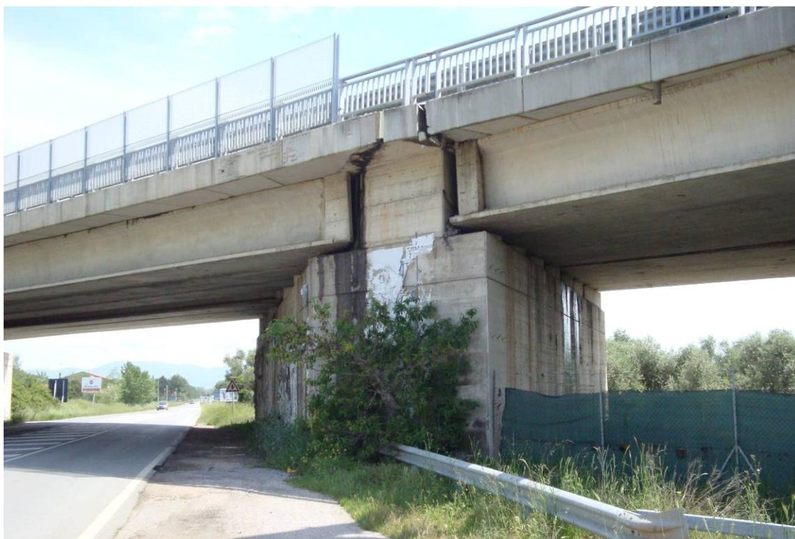
*Foto 5 – Particolare appoggio degli impalcati sulla pila con setto a V*
