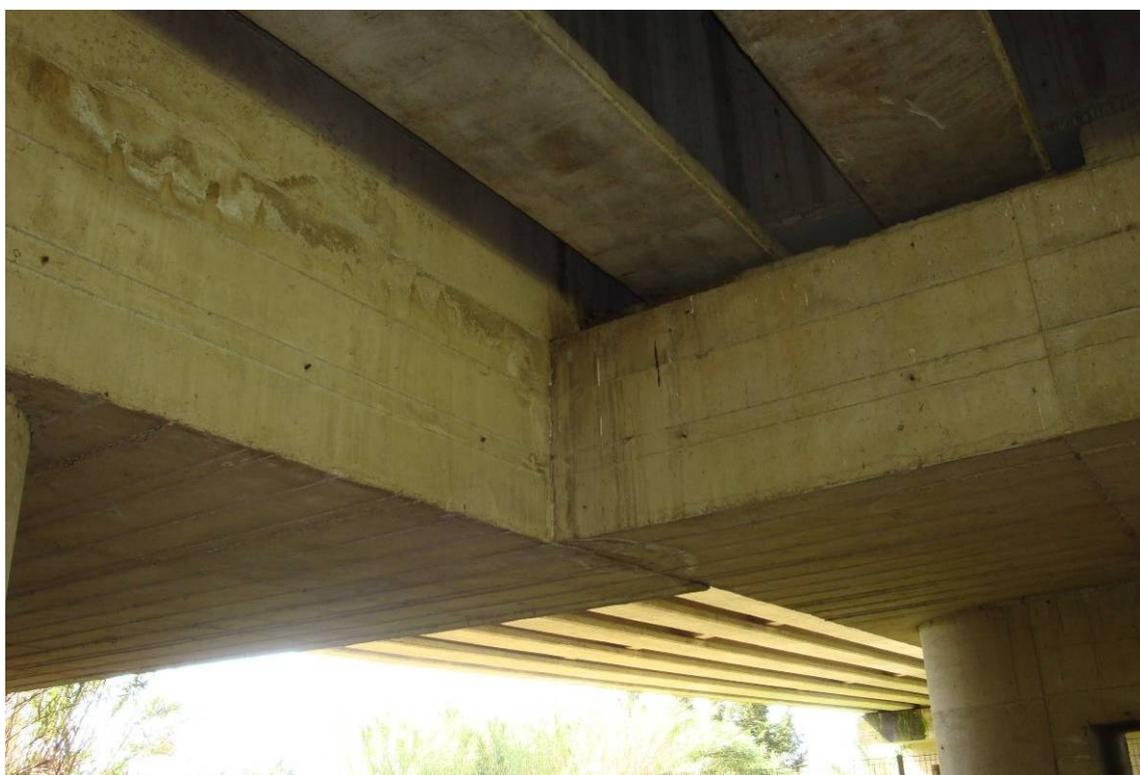
*Foto 18 – Particolare giunto tra i pulvini delle 2 pile*
