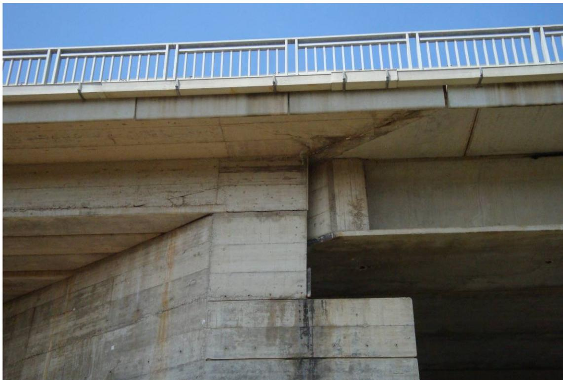
*Foto 11 – Particolare appoggio degli impalcati sulla pila con setto a V*
