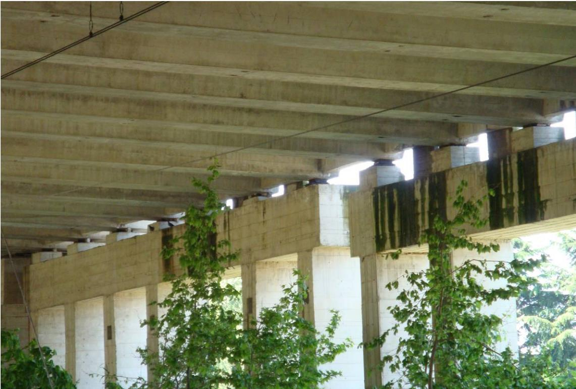
*Foto 13 – Sottovia ferroviario – telai di appoggio – scoloriture e dilavamento cls.*
