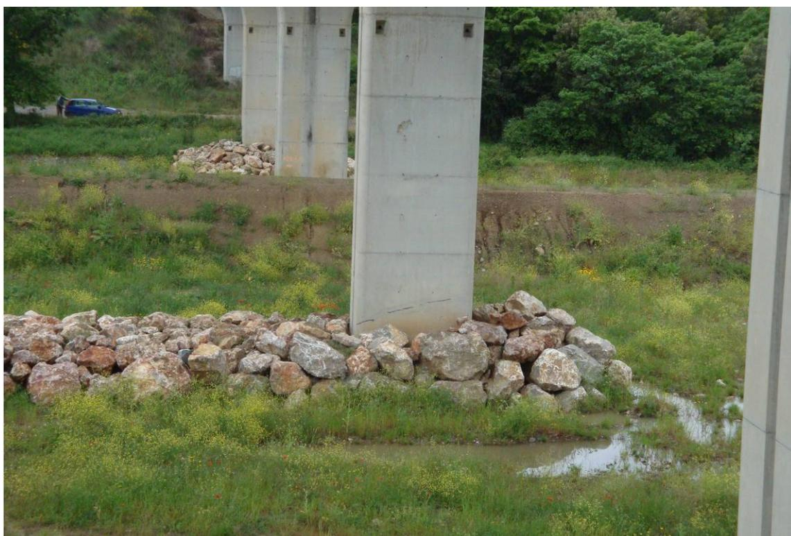
*Foto 8 – Particolare pila – protezione contro lo scalzamento*
