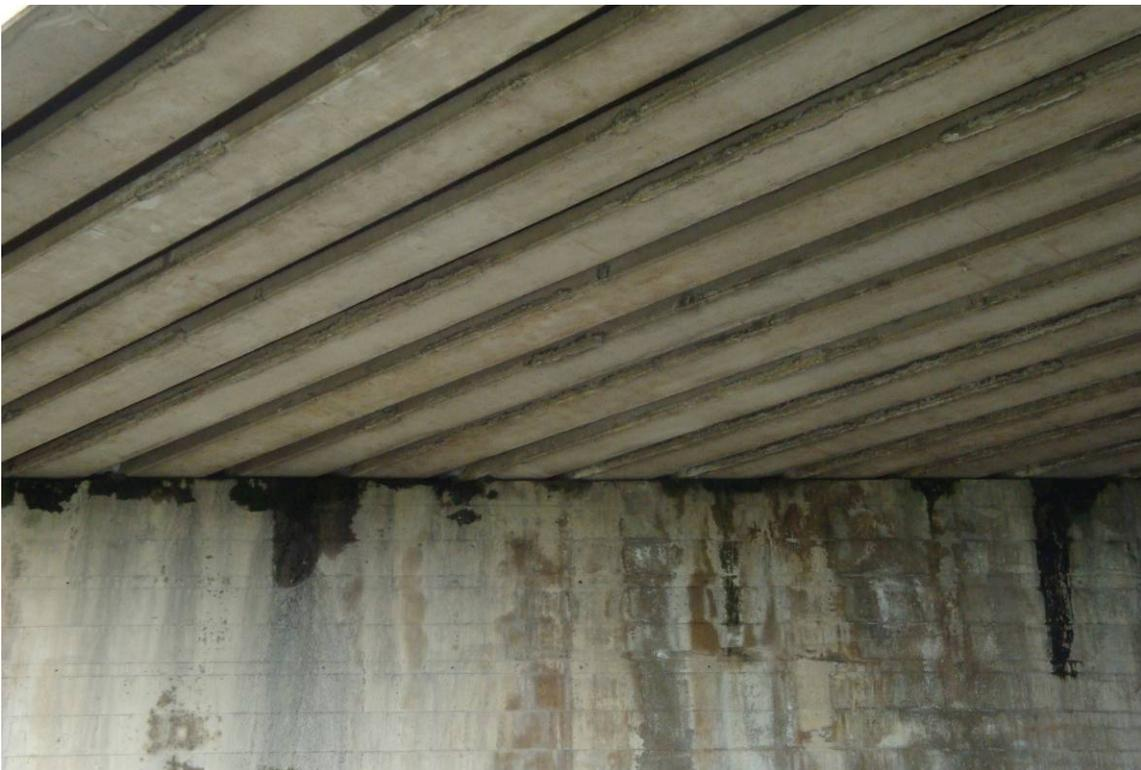
*Foto 4 – Vista intradosso e spalla – scolature sulle spalle*
