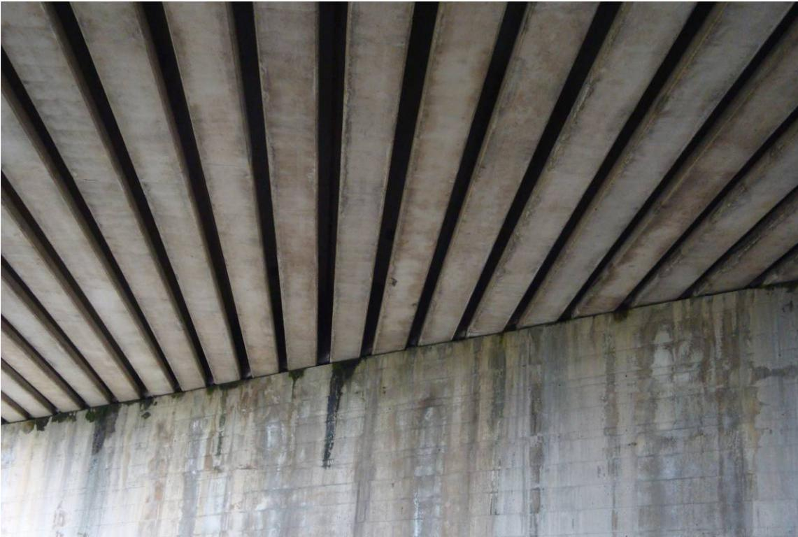
*Foto 3 – Vista intradosso e spalla – scolature sulle spalle*
