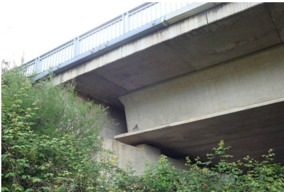
*Foto 7– Vista appoggio travi - spalla*
