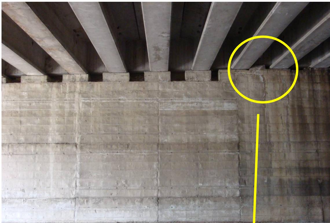
*Foto 9 – Particolare spalla – baggioli di appoggio*
