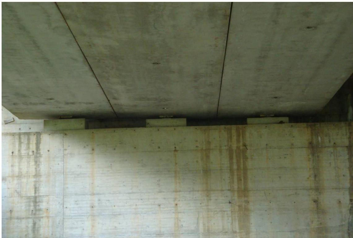
*Foto 5 – Vista intradosso e appoggio delle travi sulla spalla*
