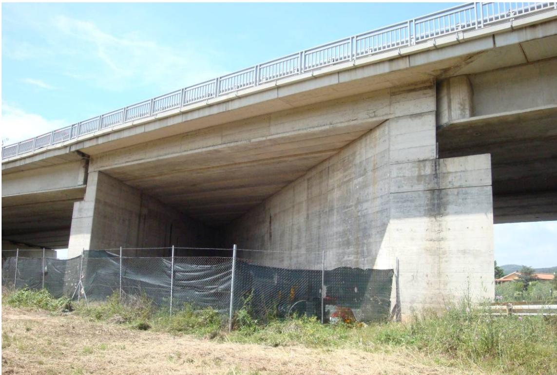
*Foto 8 – Vista laterale – interno della pila con setto a V*
