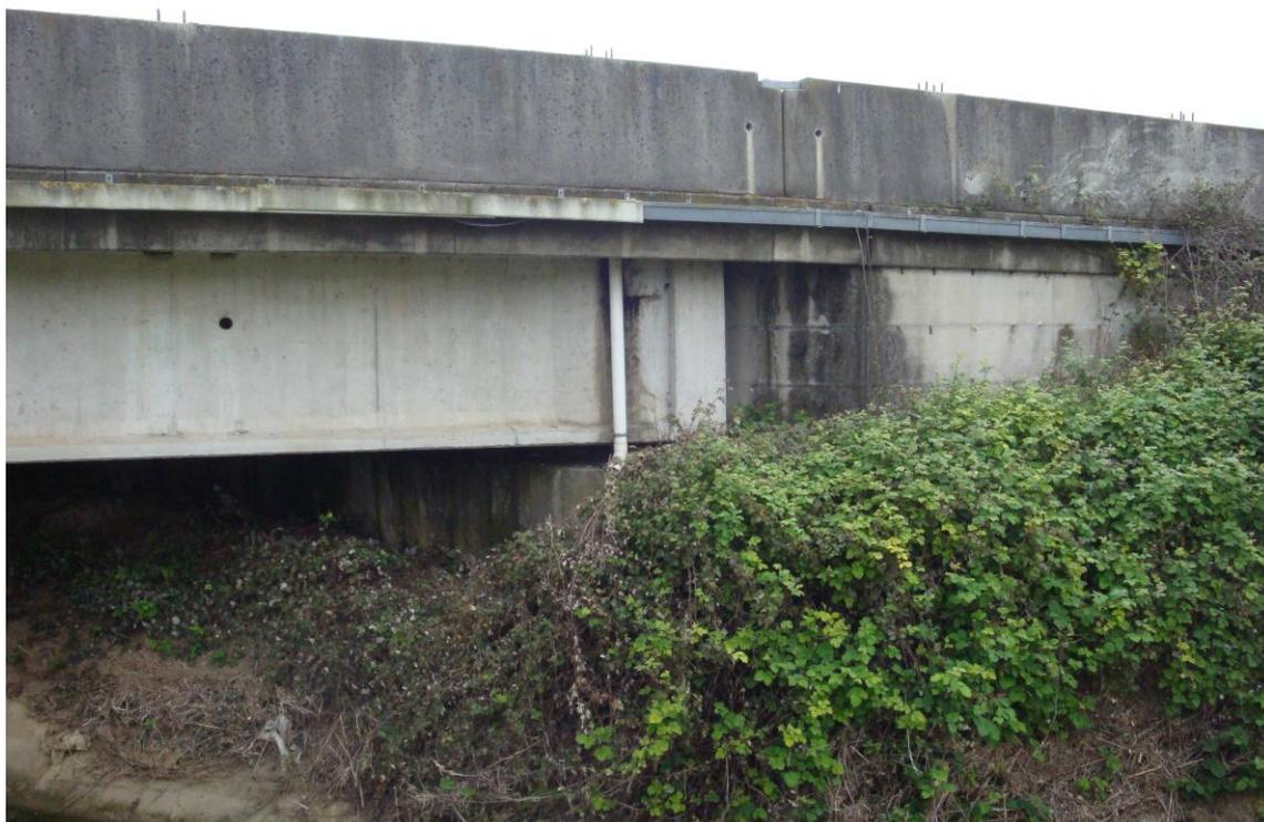
*Foto 6 – Appoggio trave e muro andatore della spalla*
