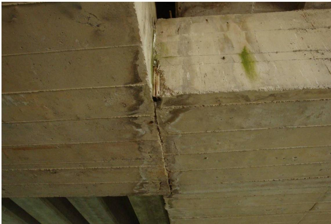
*Foto 19 – Particolare giunto tra i pulvini delle 2 pile*
