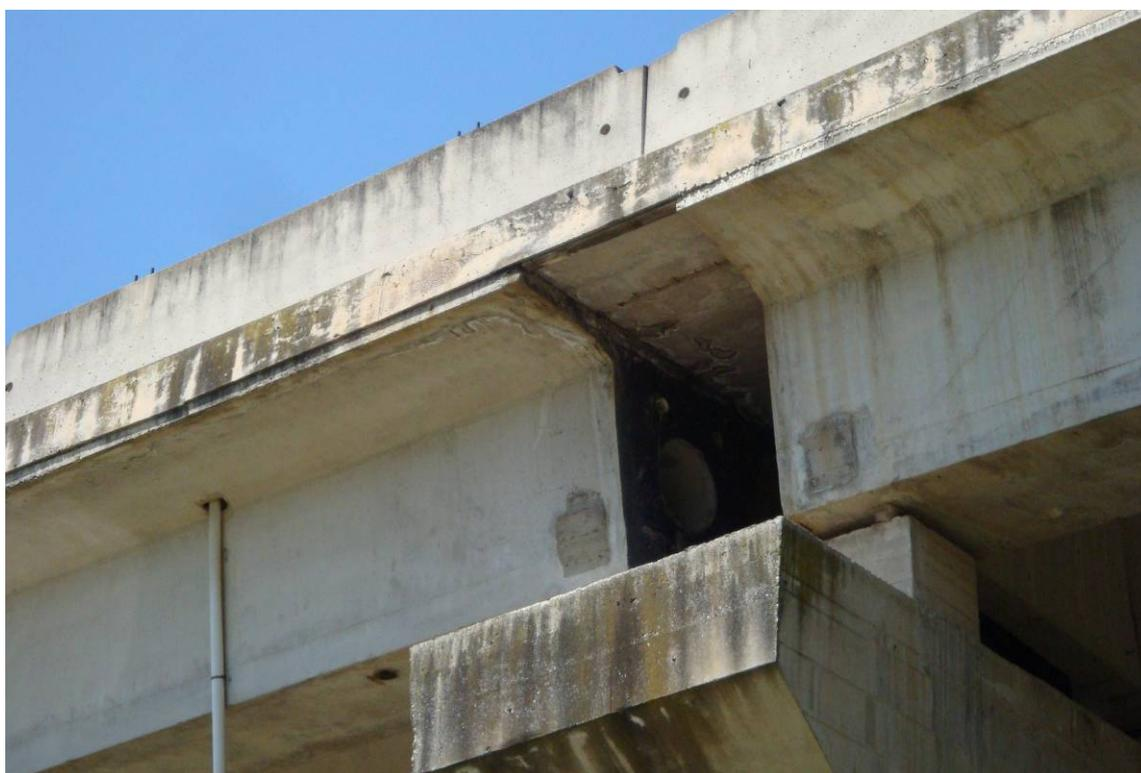
*Foto 10 – Viadotto d'accesso - particolare pulvino e testata travi*
