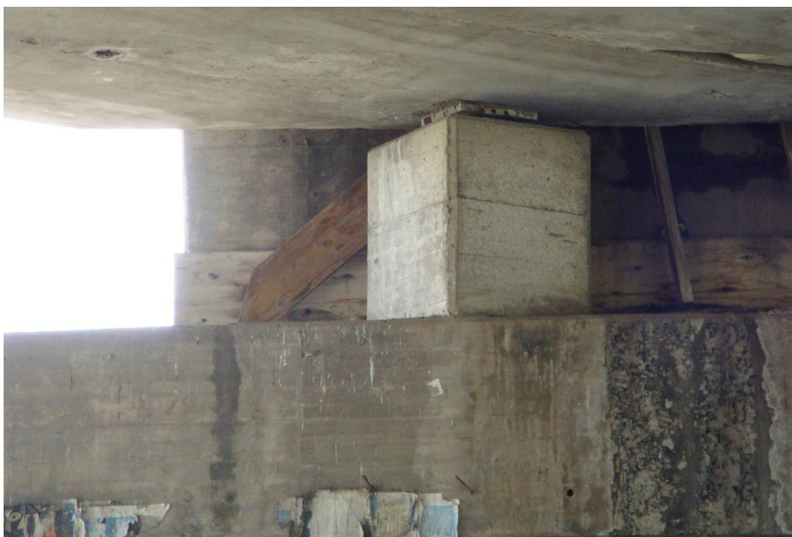
*Foto 20 – Particolare appoggi delle travi sulla pila con setto a V*
