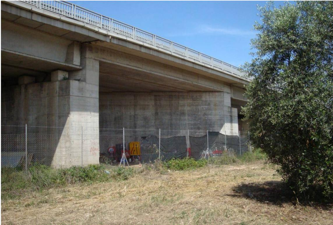
*Foto 7 – Vista laterale – interno della pila con setto a V*
