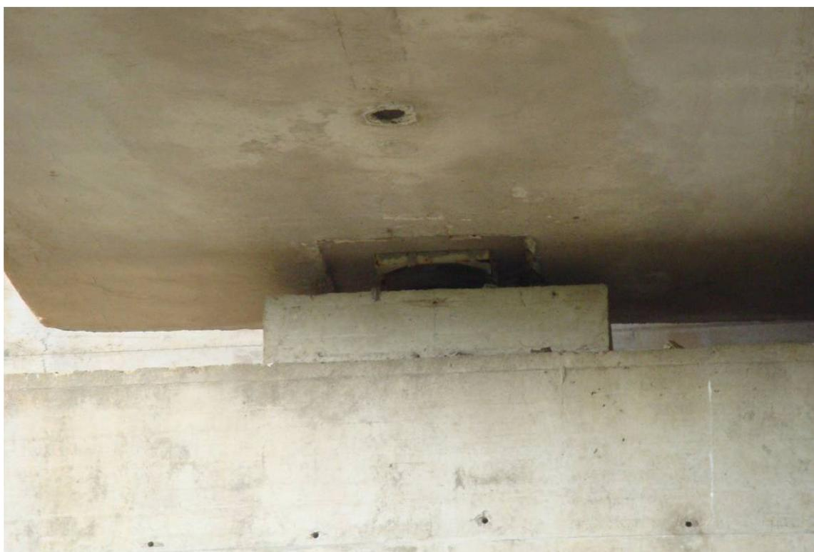
*Foto 8 – Particolare apparecchio d'appoggio in acciaio-teflon*
