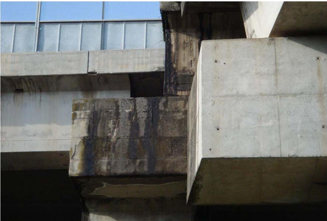
*Foto 18 – Particolare pulvini nella zona di innesto tra sottovia e viadotto*
