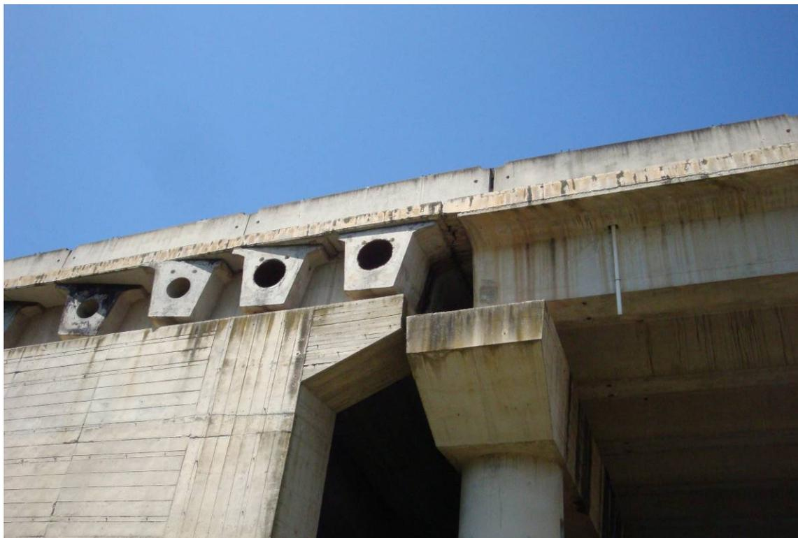
*Foto 11 – Innesto tra viadotto d'accesso e sottovia ferroviario*
