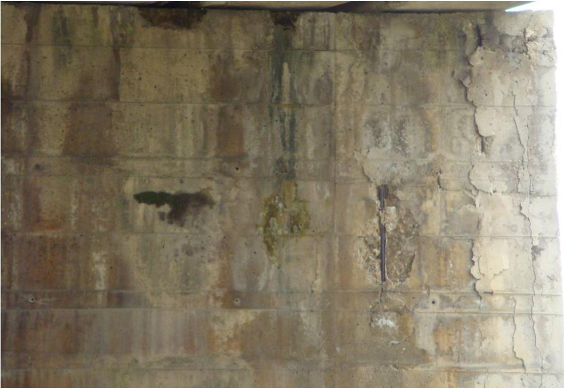
*Foto 7 – Particolare spalla – distacco copriferro e armature scoperte*
