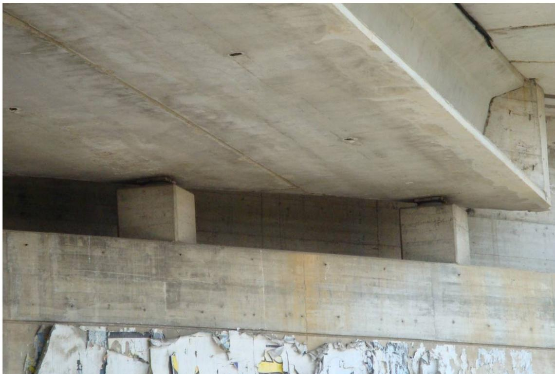
*Foto 19 – Particolare appoggi delle travi sulla pila con setto a V*
