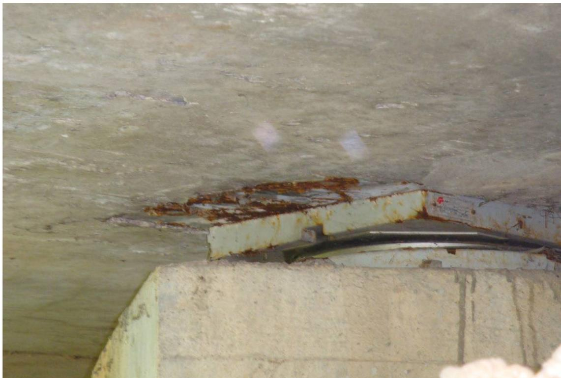
*Foto 7– Particolare apparecchio d'appoggio in acciaio teflon*
