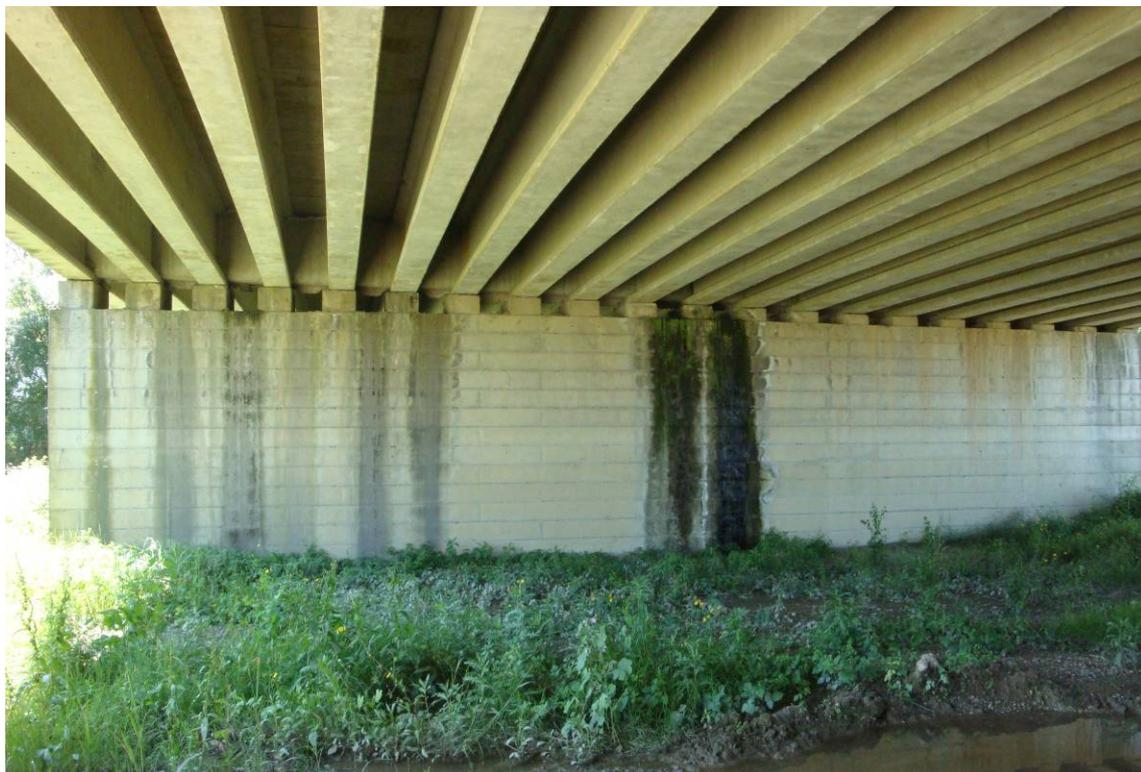
*Foto 3 – Vista intradosso e pila – scolature sulla pila*
