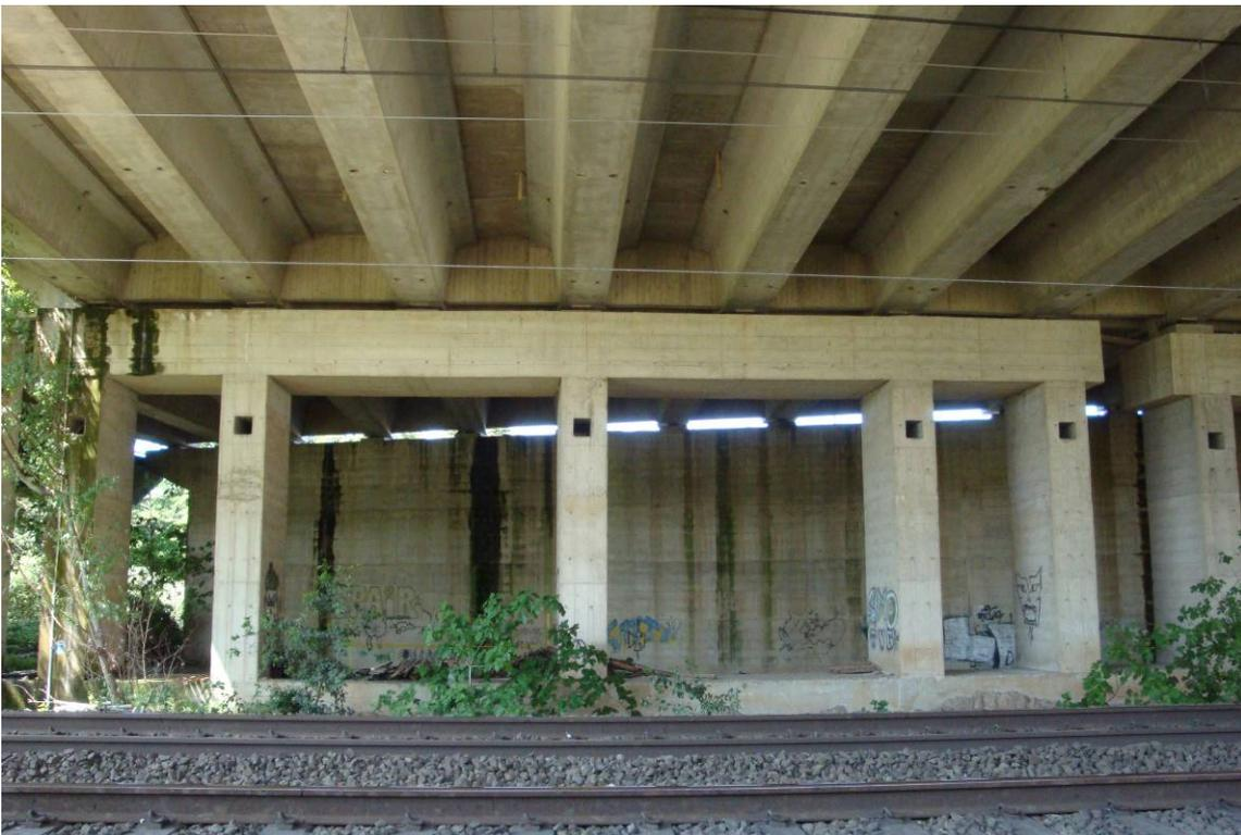
*Foto 14 – Sottovia ferroviario – telai di appoggio – scoloriture e dilavamento cls*
