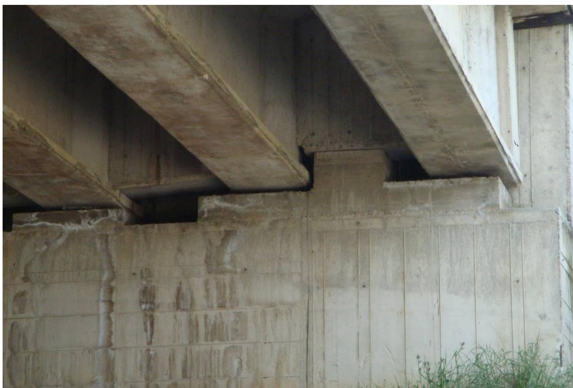
*Foto 4 – Particolare ritegni sismici trasversali*
