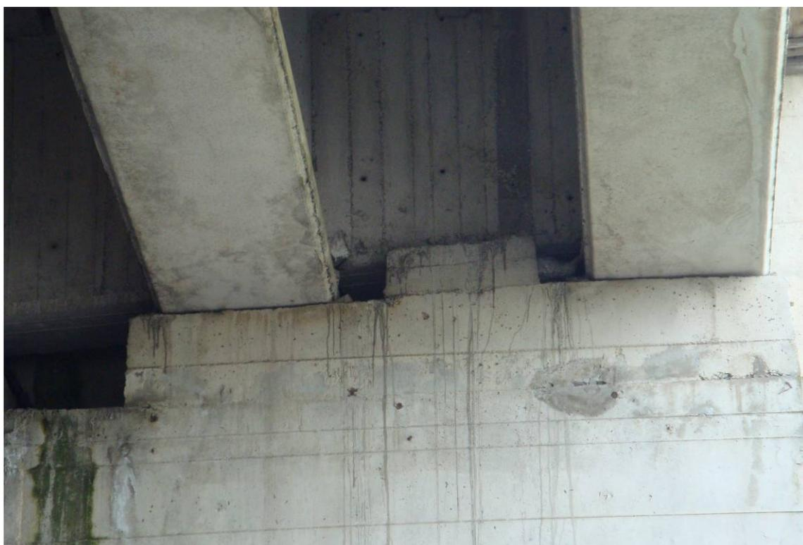
*Foto 10 – Particolare ritegno sismico trasversale*
