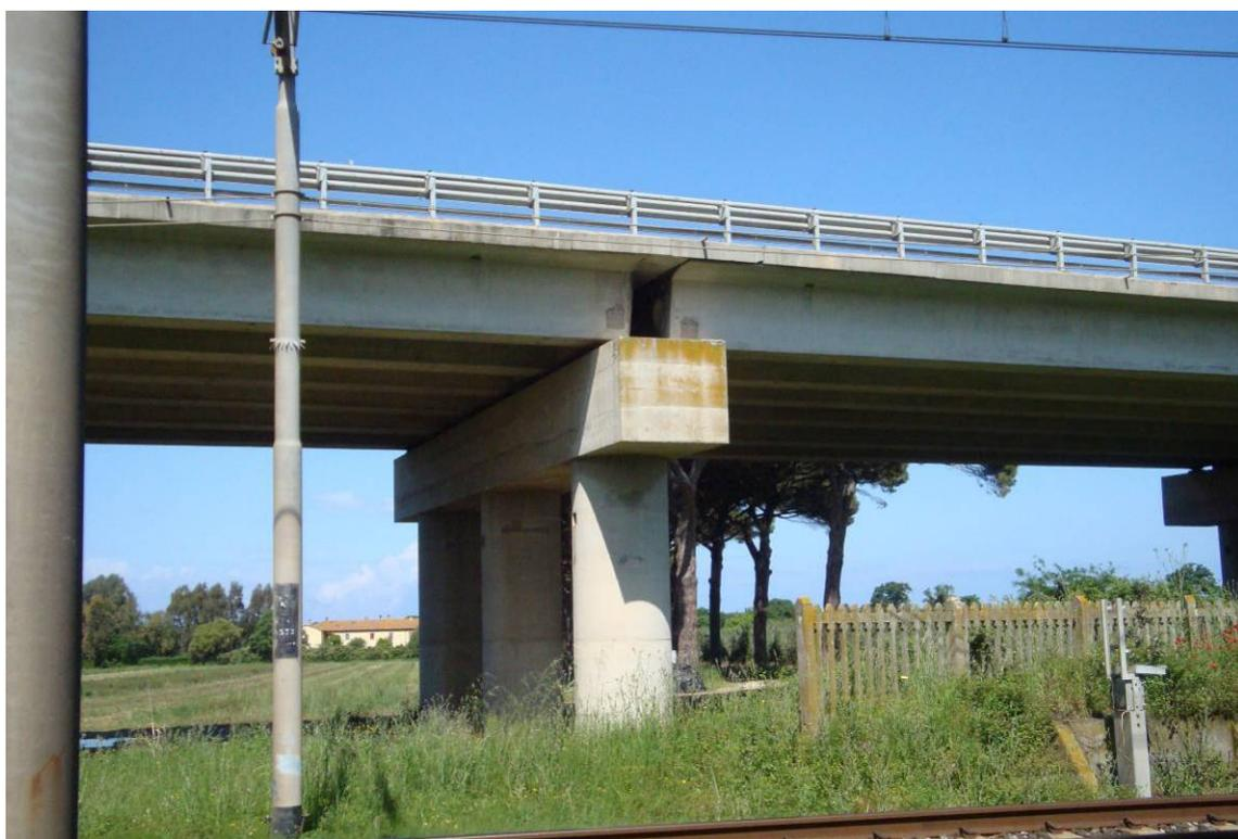
*Foto 12 – Viadotto d'accesso - pulvini e pile*
