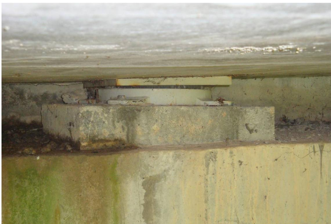
*Foto 6 – Particolare appoggio in acciaio - teflon*
