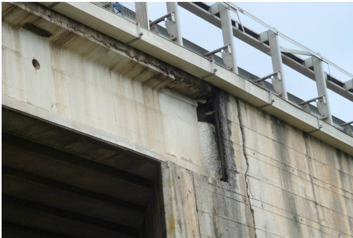
*Foto 9 – Particolare lesione spalla e ferri scoperti giunto*
