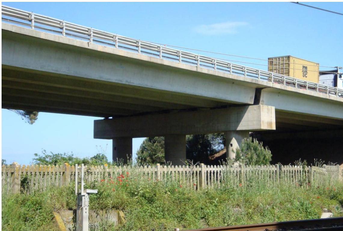
*Foto 11 – Viadotto d'accesso - pulvini e pile*
