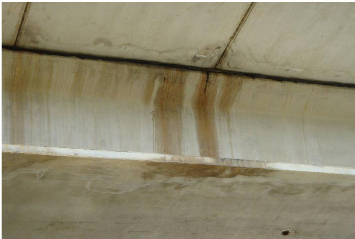
*Foto 21 – infiltrazioni e scoloriture sul fianco delle travi*
