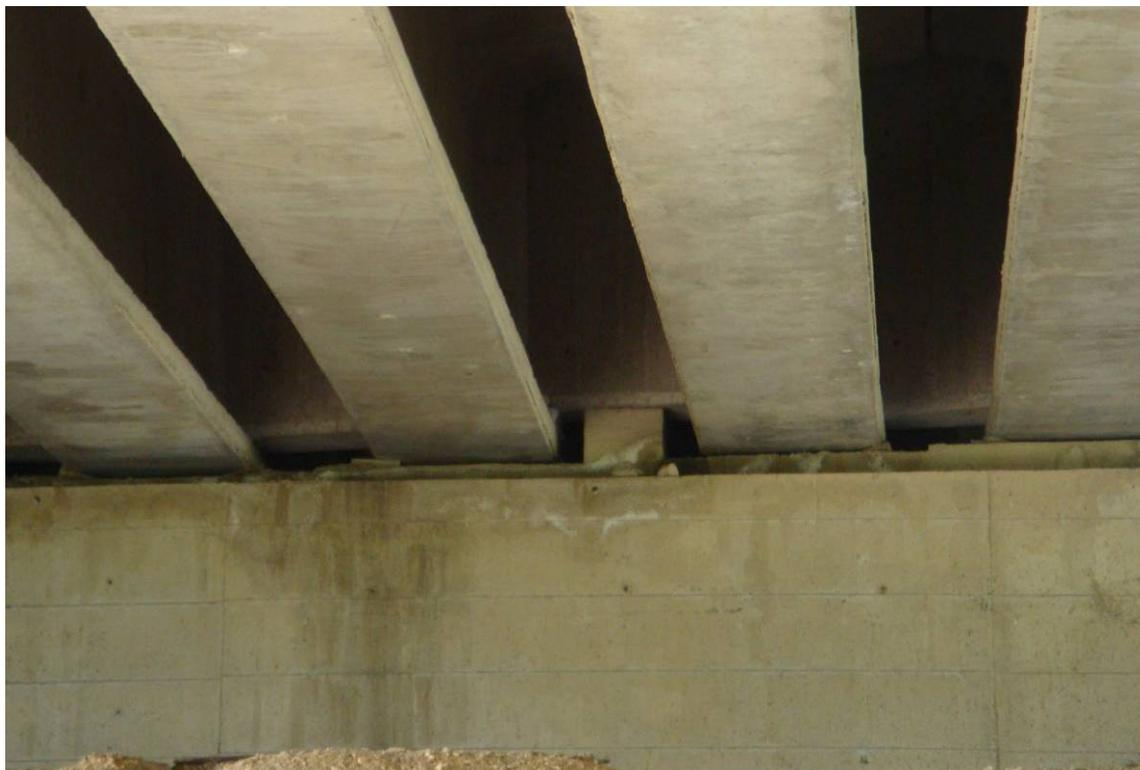
*Foto 13 – Particolare appoggio delle travi sulla spalla – ritegno sismico*
