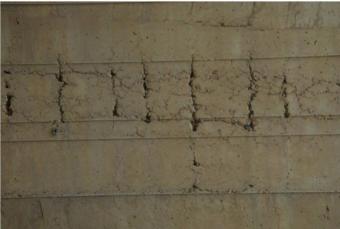
*Foto 8 – Particolare spalla – segregazione cls. e armature scoperte*
