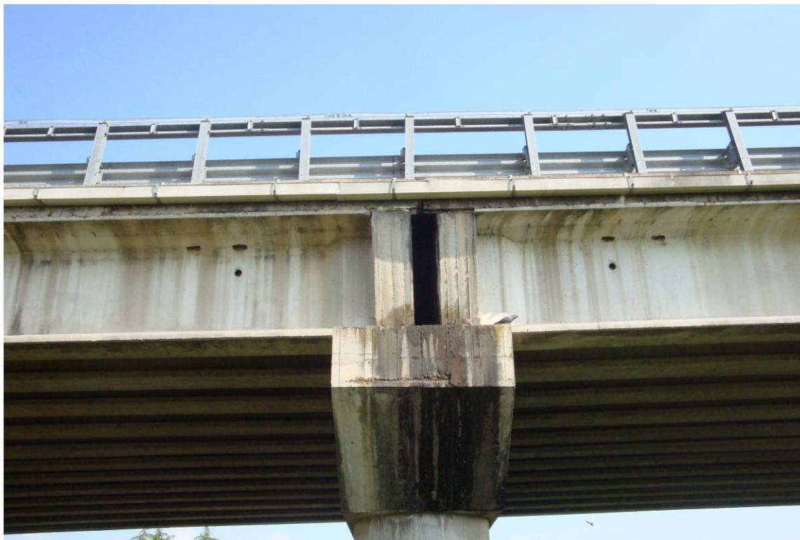
*Foto 15 – Vista degrado travi e pulvino*
