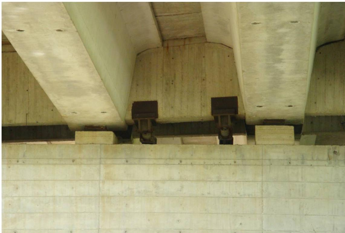
*Foto 17 – Viadotto d'accesso – ritegni sismici tra pulvino e traverso dell'impalcato*
