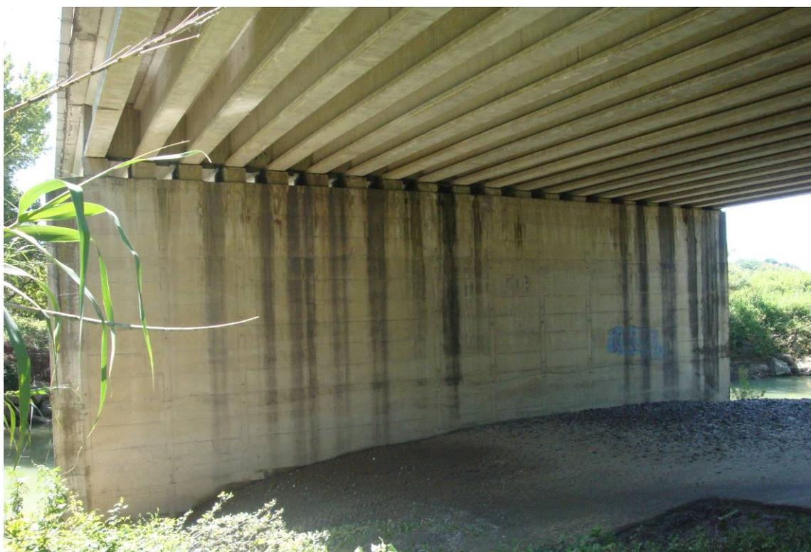
*Foto 6 – Vista intradosso e pila in alveo – scolature sulla pila*
