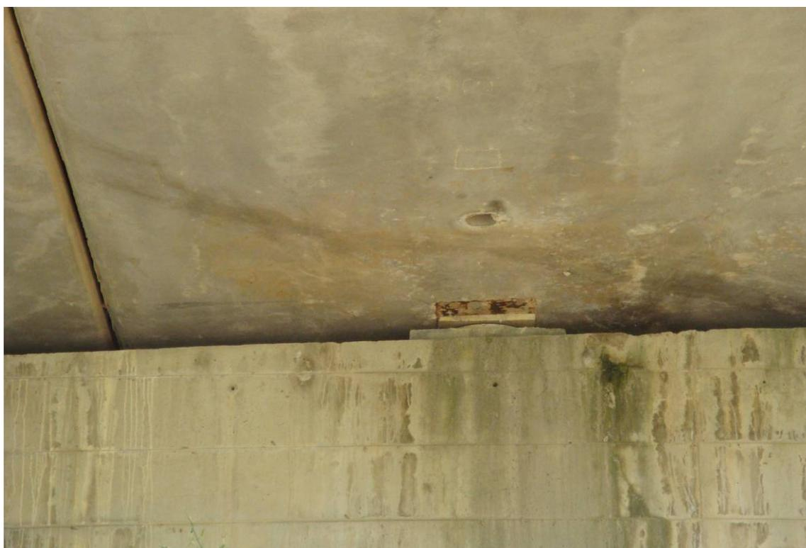
*Foto 6 – Particolare apparecchio d'appoggio in acciaio-teflon*
