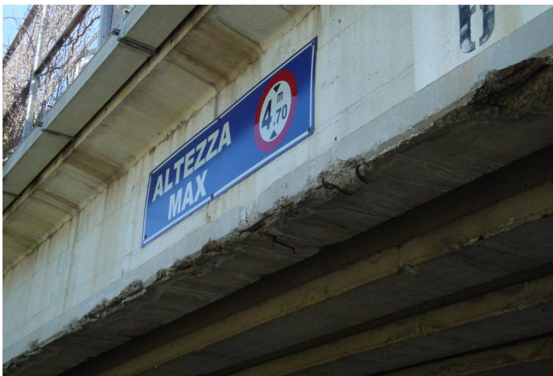
*Foto 8 – Particolare trave di bordo – distacco copriferro e armature scoperte*
