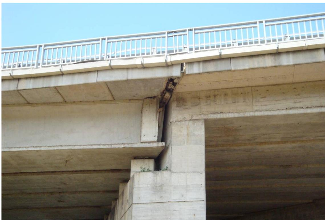
*Foto 10 – Particolare appoggio degli impalcati sulla pila con setto a V*
