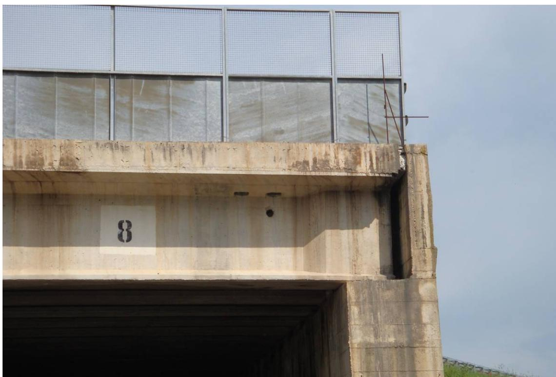
*Foto 4 – Particolare della testata del sottovia – dilavamento del cls.*
