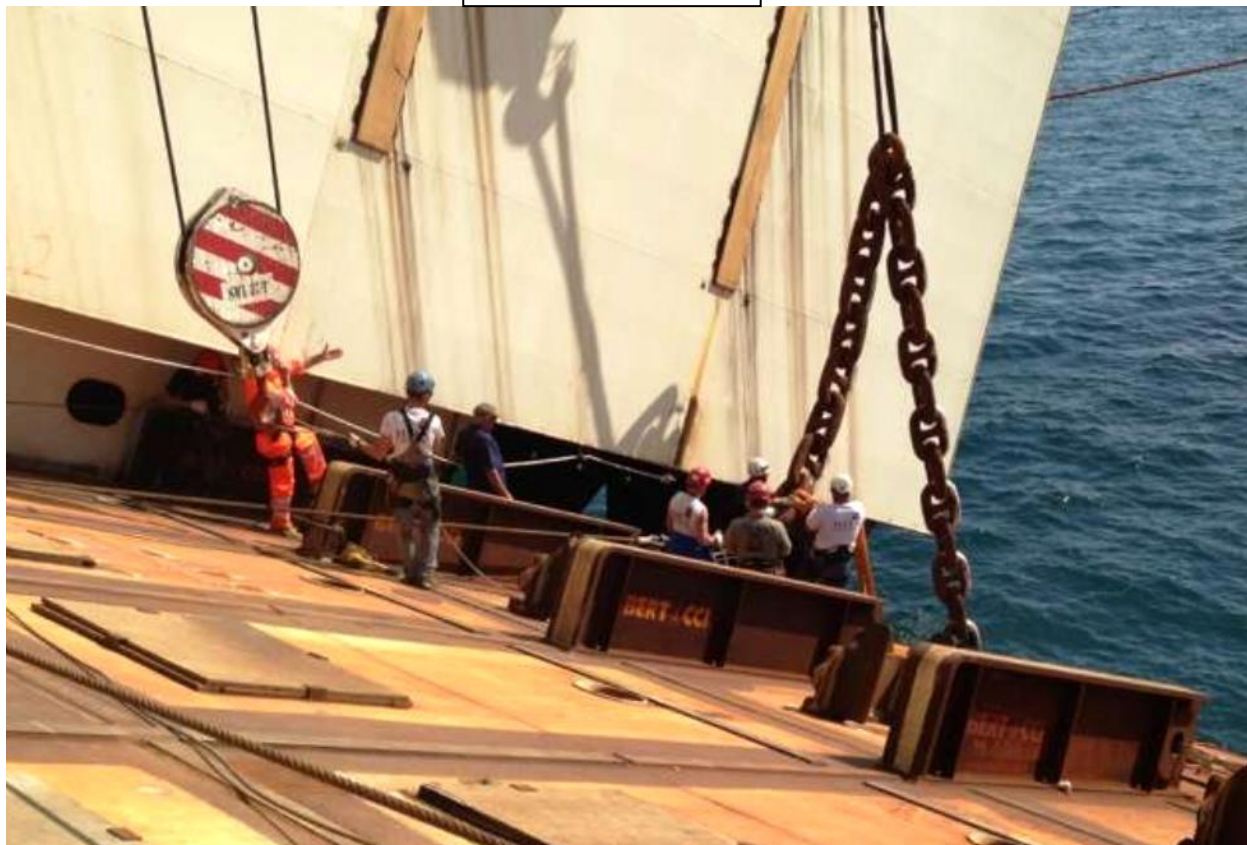
Installazione catene per il sistema di ritenuta
