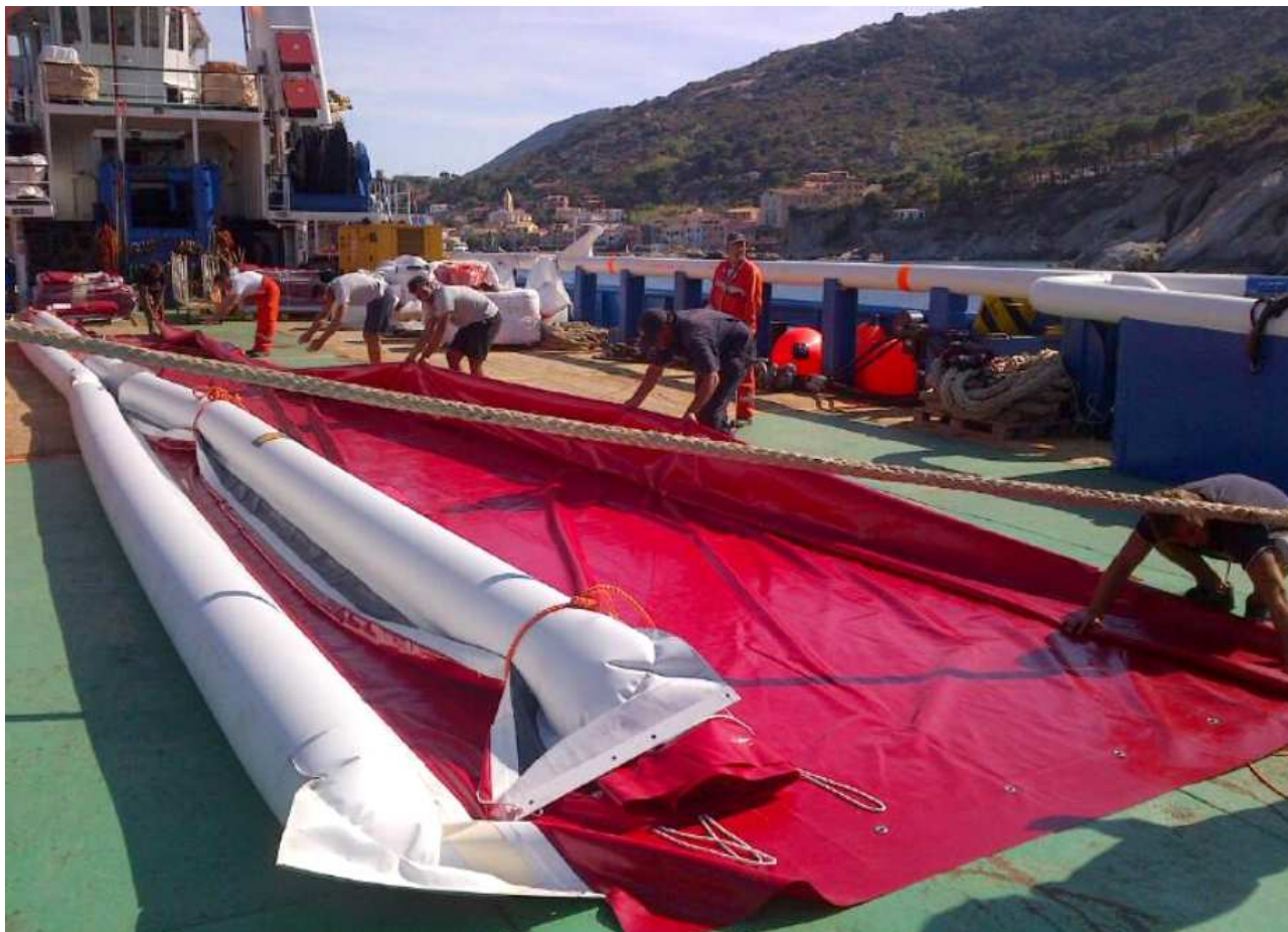
Sopra: Assemblamento panne di contenimento anti-torbidità a bordo del rimorchiatore Snipe Sotto: operazioni di trasferimento materiale tramite elicottero
