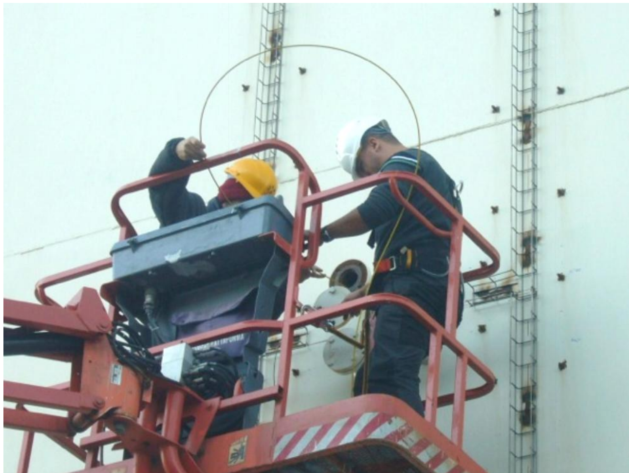
Operazioni di allestimento dei cassoni di spinta, ruotati, a Livorno
