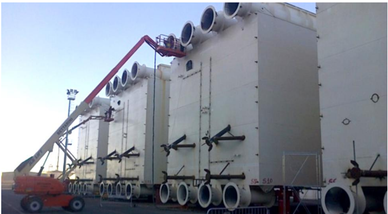
Sotto: Operazioni di allestimento dei cassoni di spinta, ruotati, a Livorno
