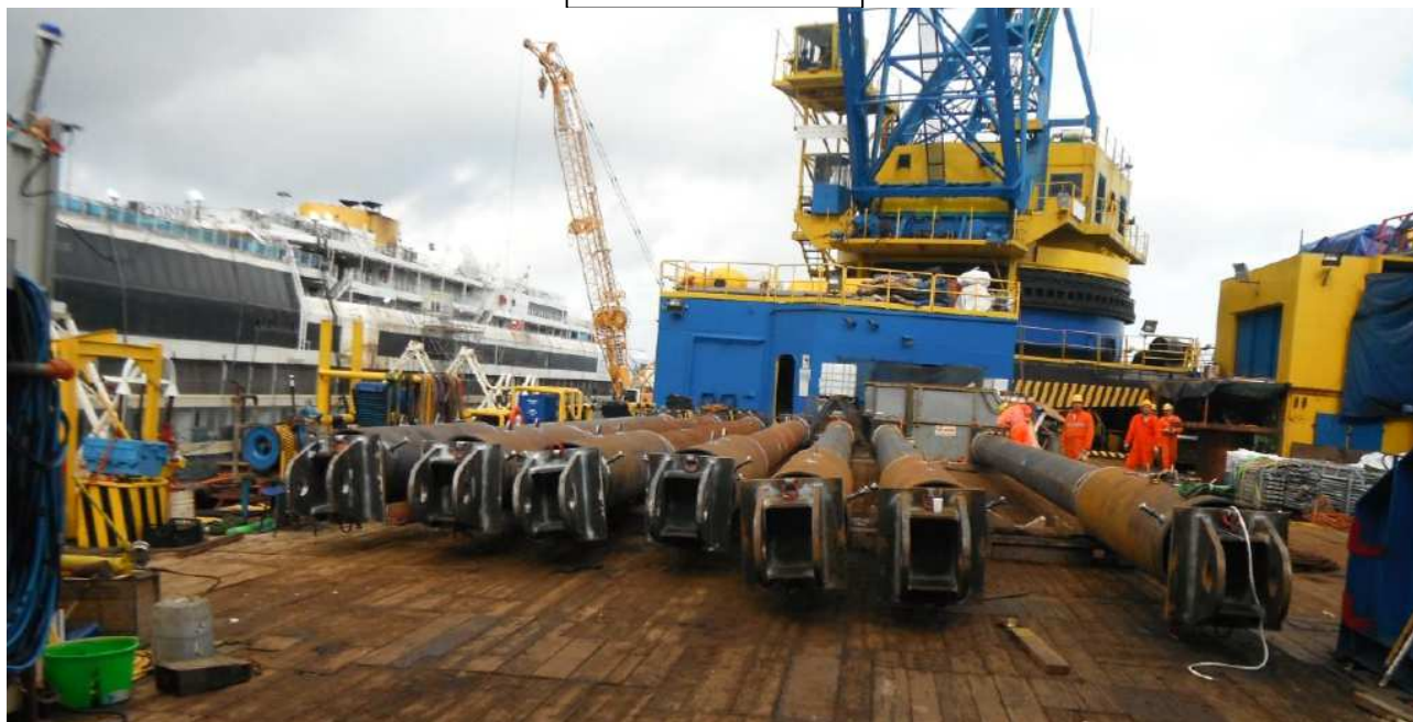
Supporti Tubolari di collegamento tra piattaforme e cassoni
