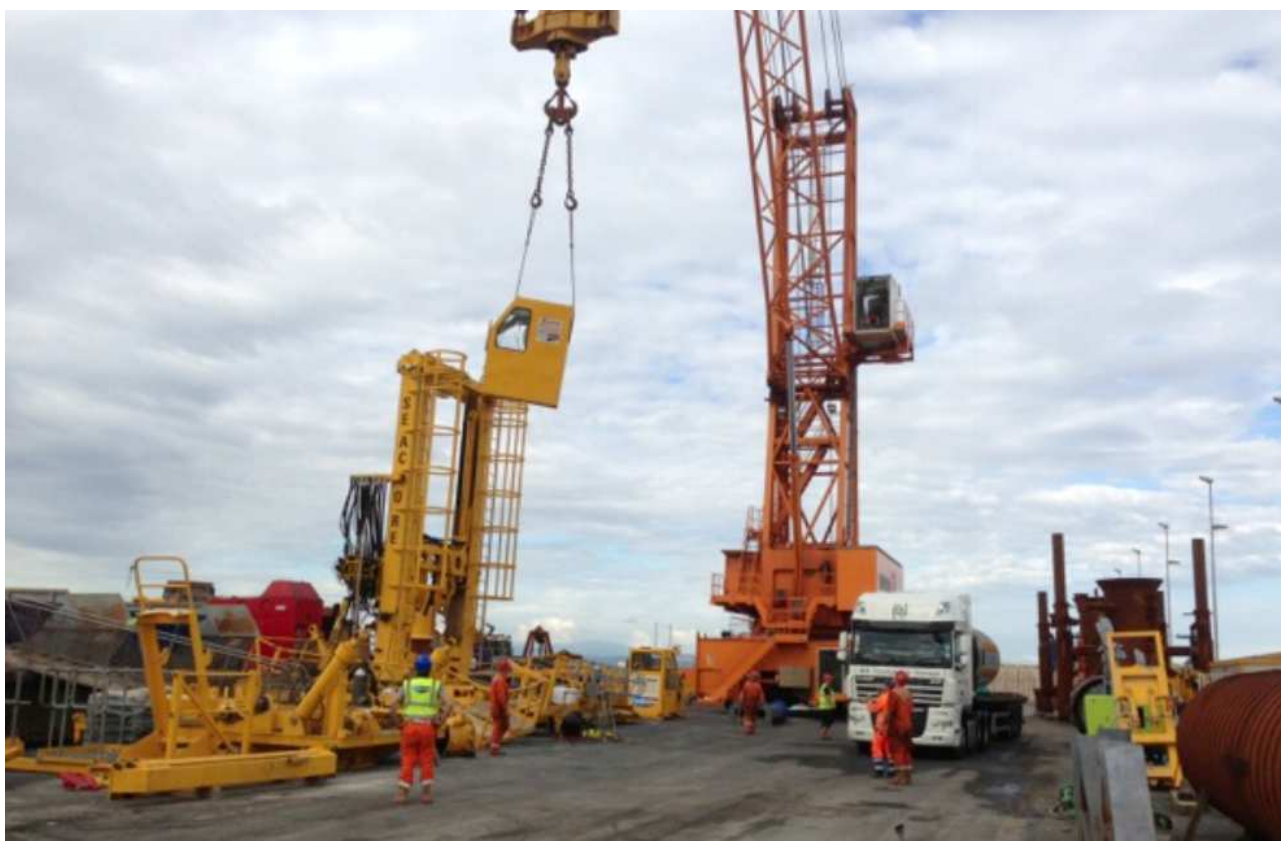
Sopra: Rimozione dima in preparazione installazione piattaforma 2 Sotto: assemblaggio nuova torre di controllo per trivellazioni a Piombino
