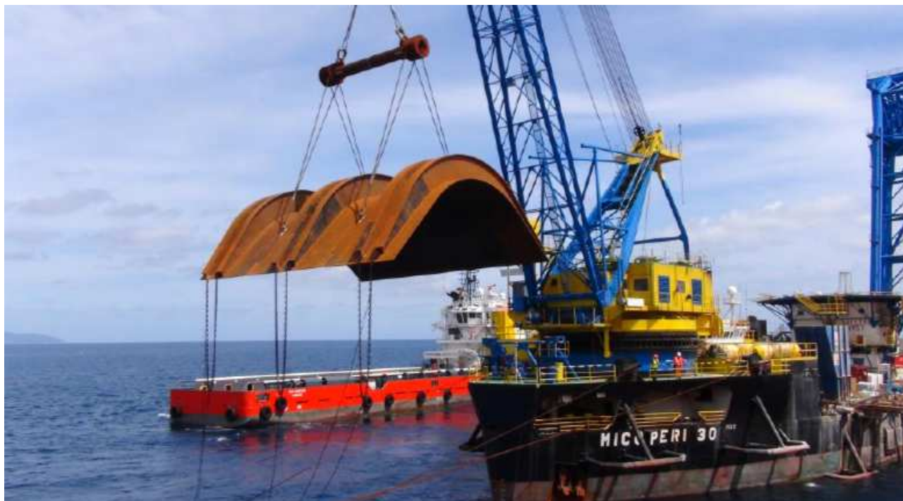
Installazione seconda gash Plate sulla falla per posizionamento catene per sistema di ritenuta
