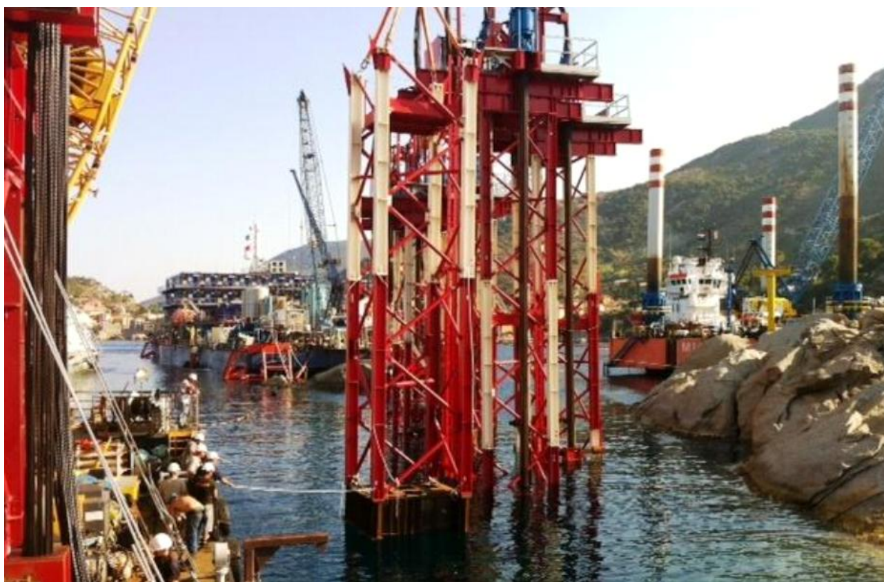
Collegamento degli Strand Jacks al cassone P10 Installazione parte inferiore della torre su anchor block 10
