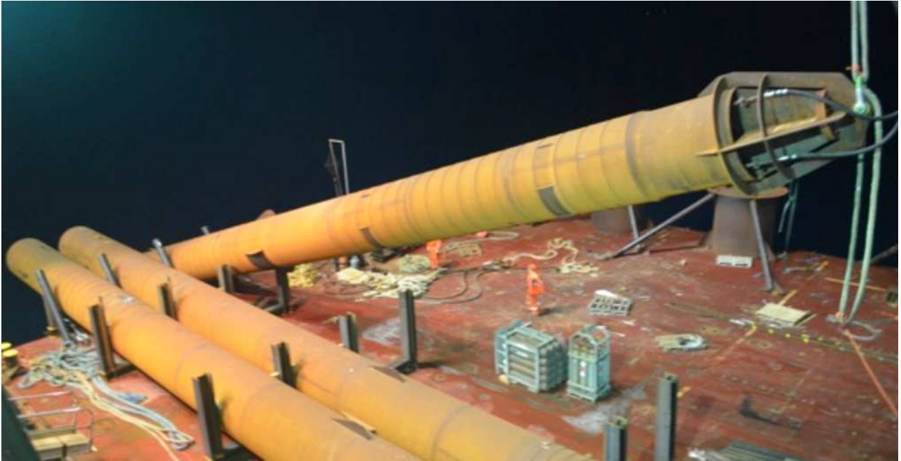
Operazioni di posizionamento pali per installazione piattaforma 2
