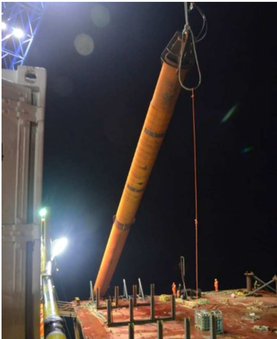
Operazioni di posizionamento pali per installazione piattaforma 2
