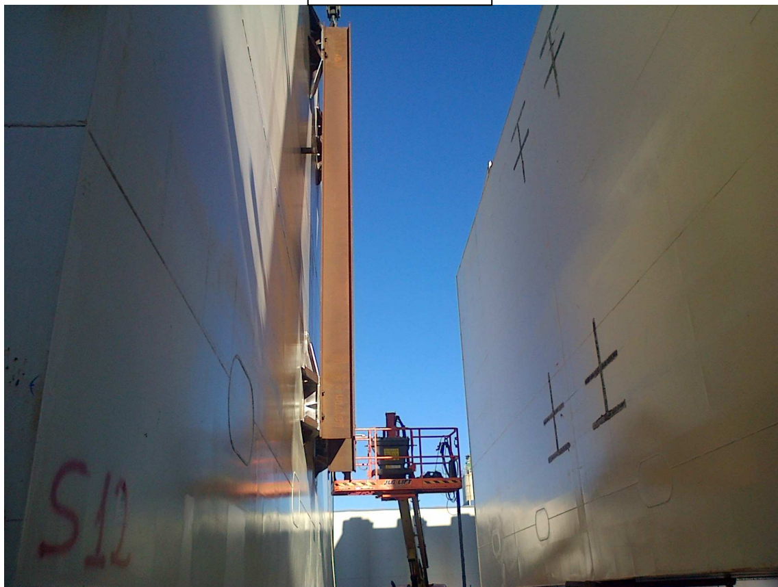
Installazione supporti per la rotazione dei cassoni
