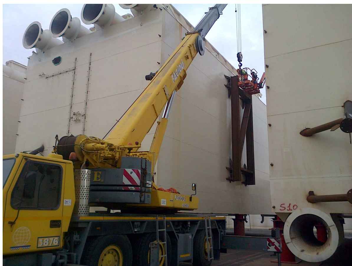
Installazione supporti per la rotazione dei cassoni
