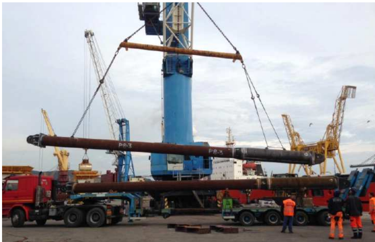
Sopra: Primi 4 supporti tubolari di collegamento pronti per essere trasportati in area di lavoro
